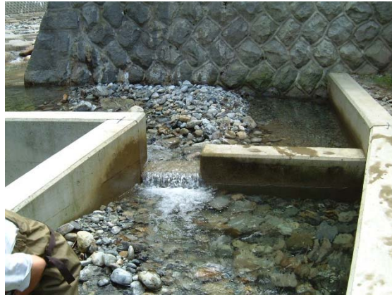
図-5 魚道に流入した土砂
