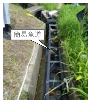
図一12 簡易魚道の設置
