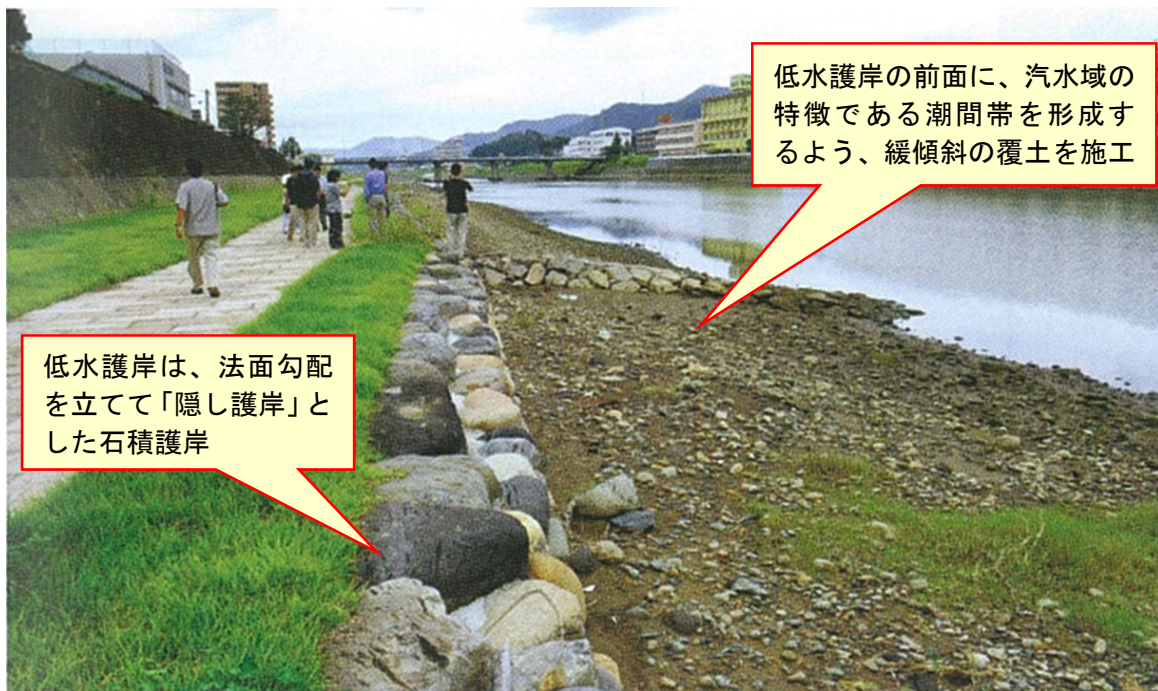
図-10 護岸前面に汽水域の特徴である潮間帯を形成（五ヶ瀬川） 写真：吉村伸一
