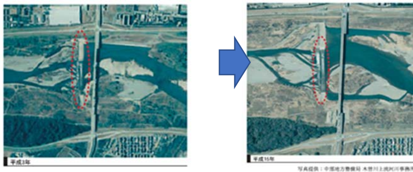
図-4 滞筋の変化の例 滞筋の変化により、床固工（円内）上下流の砂州形状が変動している。
