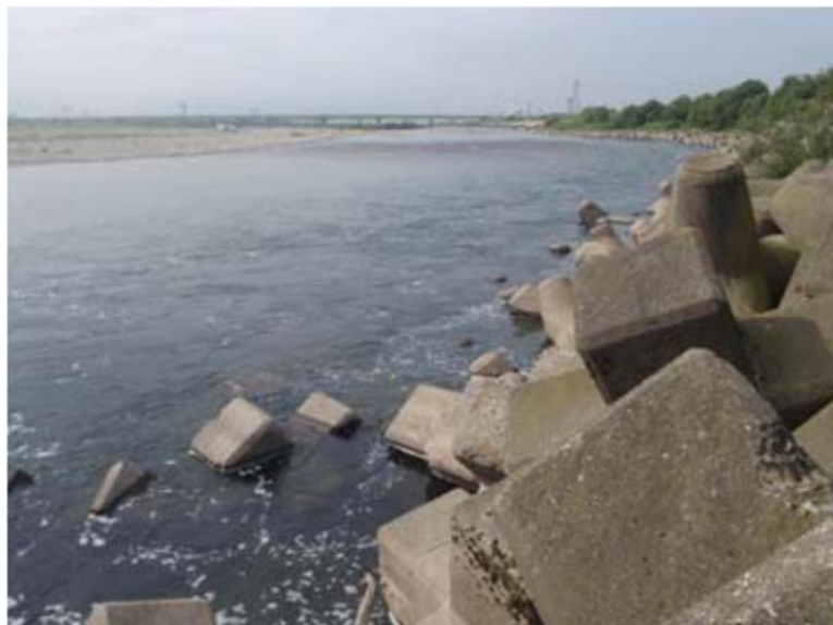
図-13 水衝部の淵のブロック（神通川）
