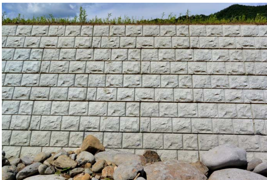
図-26 ブロック内に模様目地を付けた大型ブロック
