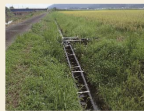
水田 - 水路間の魚類の移動を 目指して設置された水田魚道
