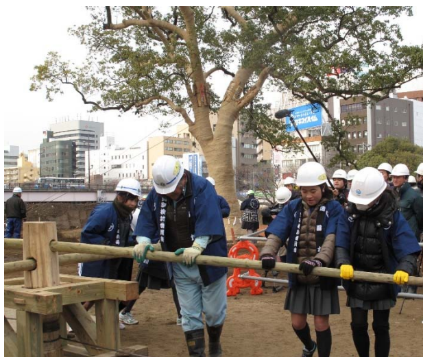
写真-11 大クスノキの移植の様子 11) 。小学校の生徒や市民も参加して滑車を動かす（写真右）
