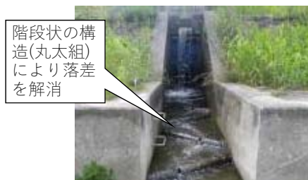
図一10 樋管の吐口部の改良
