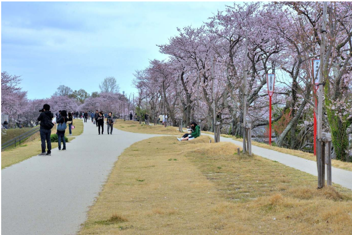
写真-4 本堤防（左 7m）と側帯（右 5m）。左隅に見える突出し堤は周防守堤。本堤防の河川管理用通路舗装は従前の 3m 幅とし、緑地（芝生）面積を多くとり柔らかい景観となるようにした。本堤の天端下全面に遮水シートを設置して、本堤への雨水浸透を防いでいる。支柱がついた桜が新しく植えた桜。桜の根元に配置した三日月上の小盛土は、水防活動の際に必要となる土のう材料として位置づけているが、普段はベンチとして利用を想定してデザインしたものである（月ノ輪と名付けた）。
