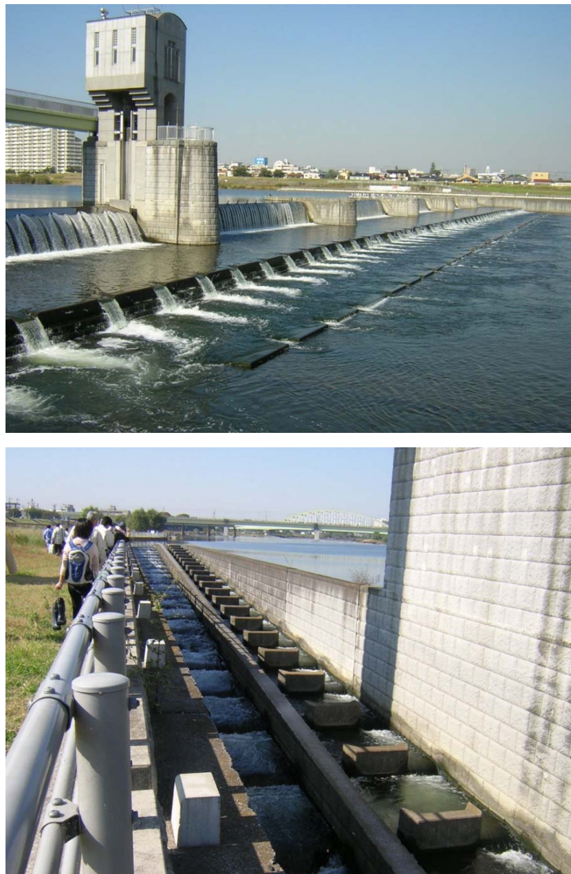
図-9 改築後の二ヶ領宿河原堰 上：堰全景 下：魚道 （多摩川）
