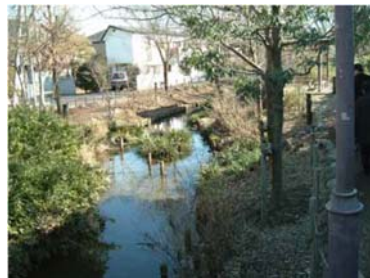
図ー7 コンクリート水路撤去の事例 4)
