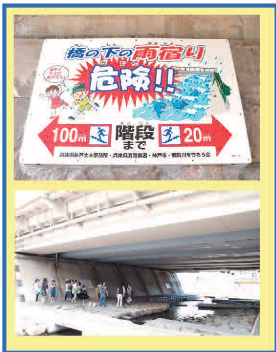
写真3-5 都賀川の看板設置事例
