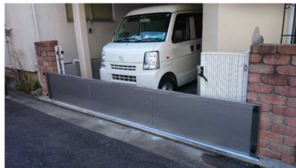
【止水板の設置例】
