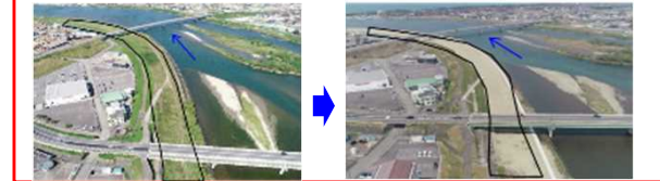
河道掘削事例（高津地区）
