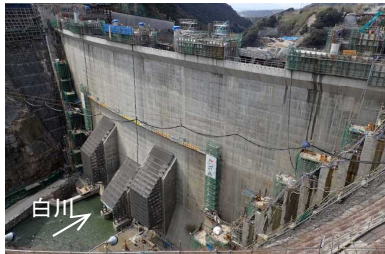
立野ダムの工事状況(令和5年3月) (上流側より望む)
