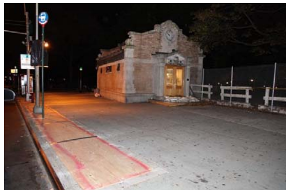
写真-2 Bowling Green 駅前。手前左は換気口の止水のためにパネルを設置した状況
