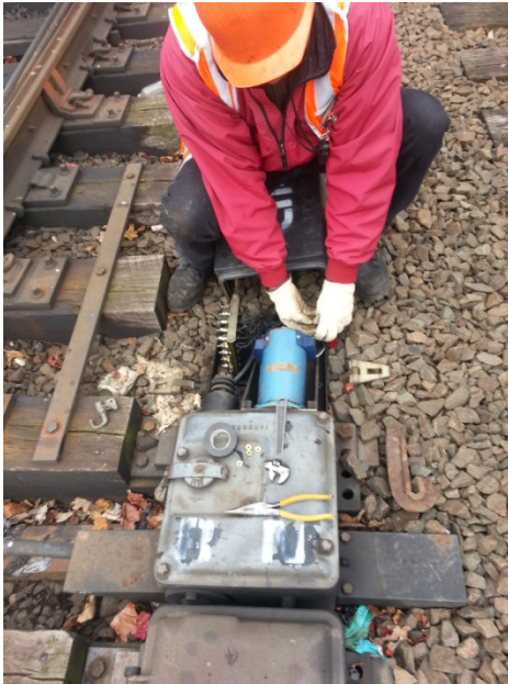
写真-6 New Heaven線のポイントからモーターを取り出す作業
