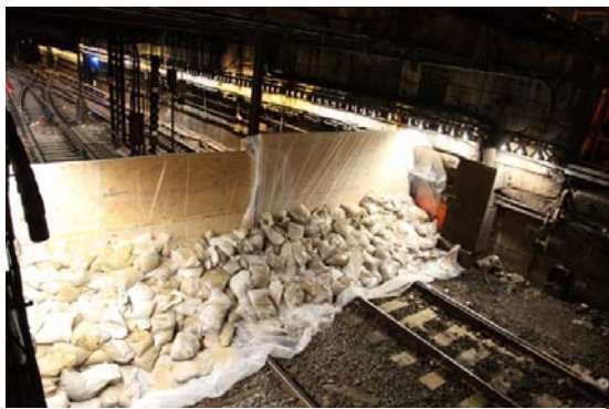
写真-1 148 st. Lenox Terminal 付近での止水状況。この構造で実際に水を止めている
