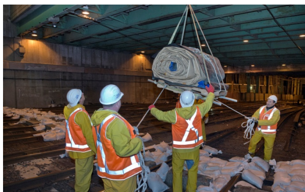
写真-3 格納している水のうを取り出すところ。 線路には水密性確保のため土のうを設置
