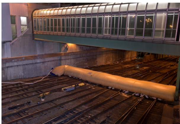
写真-5 水のうを設置し終わった状況
