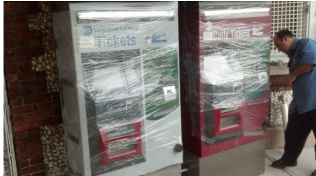
写真-7 MTAのロングアイランド線で、暴風雨に備えて券売機にシュリンク包装をかけた状況
