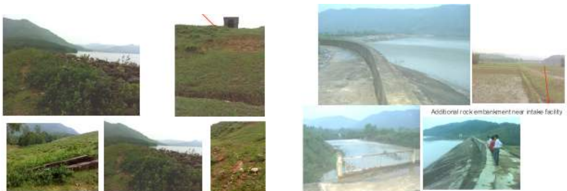
ドンランダムの漏水・陥没（左）とホーバーダム上流側の補修状況（右）
