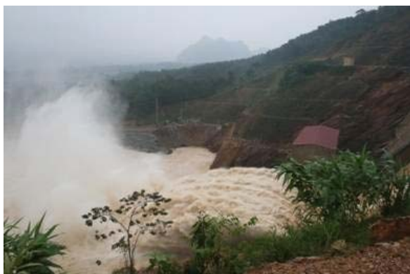
ホーホーダム左岸より右岸側の発電施設流出箇所を望む
