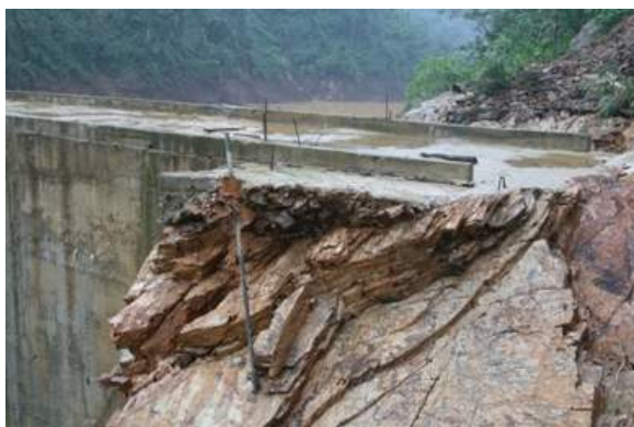
ホーホーダム左岸。堤体越流により岩盤の一部が損傷
