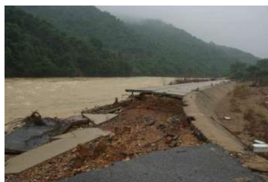
ラオソン川左岸の道路崩壊現場（10月19日撮影）
