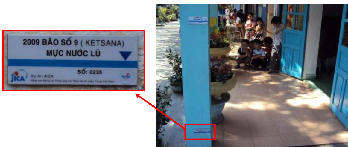
例 4: フエ省での洪水痕跡プレート設置
