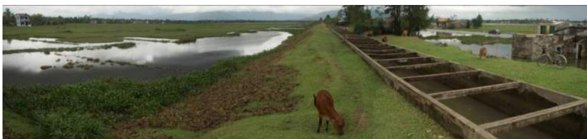
国道に並行するかんがい用水路（10月18日撮影）
