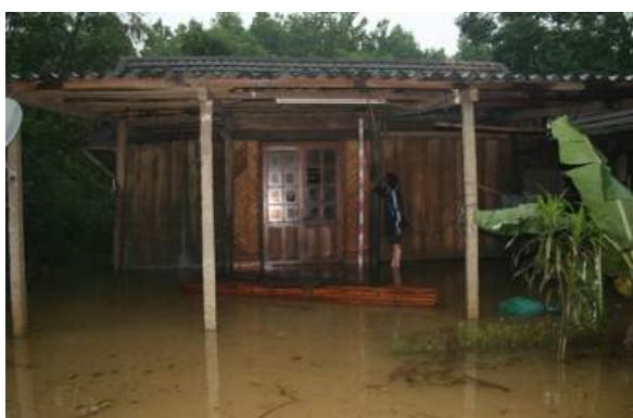
上流域では浸水深は地盤高より 3m(家屋床から 2.4m)
