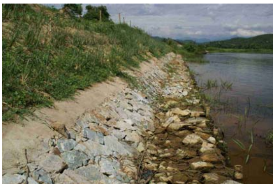
ドンプック村の護岸の状況、2009 施工直後（左）と 2010 洪水後（右）
