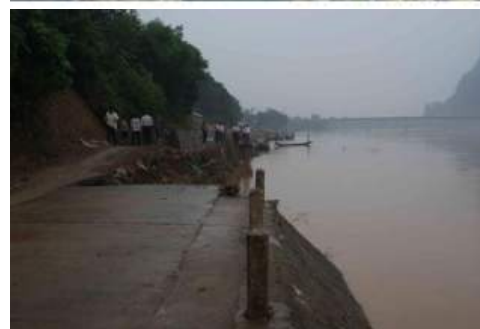
被災箇所の状況（10月19日撮影）
