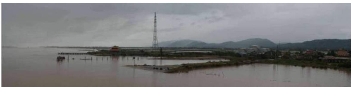
ジャン川右岸の国道1号下流側（10月18日撮影）
