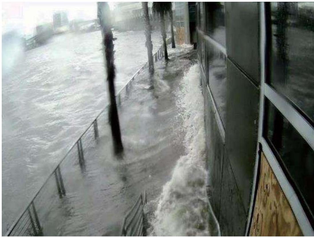
写真 2.4.2 BMC のハリケーン・イルマ襲来時の状況—設置した土のうは流れ、ベニヤ板部分から漏水が発生した
