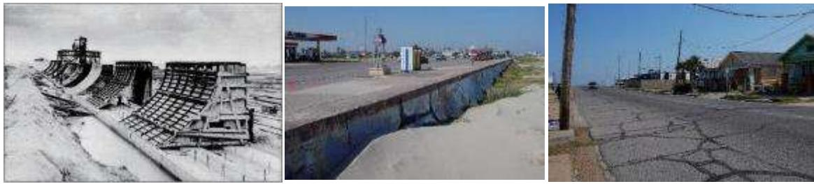
図 2.1.10 ガルベストン地区の海岸堤防（左：築堤時、中央：海側、右：陸側）
