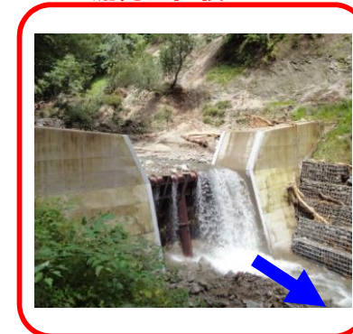
土石流発生直後 (H27.9.11)
