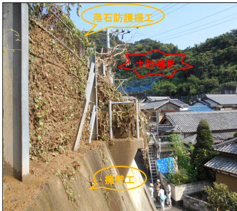
崩壊土砂補足状況
