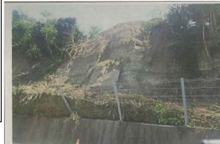
土砂や倒木を食い止めた擁壁 =2015年9月8日、浜松市西区大人見町(県提供)
