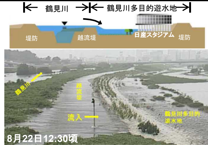
鶴見川の水位が上昇し、越流堤から鶴見川多目的遊水地に流入
