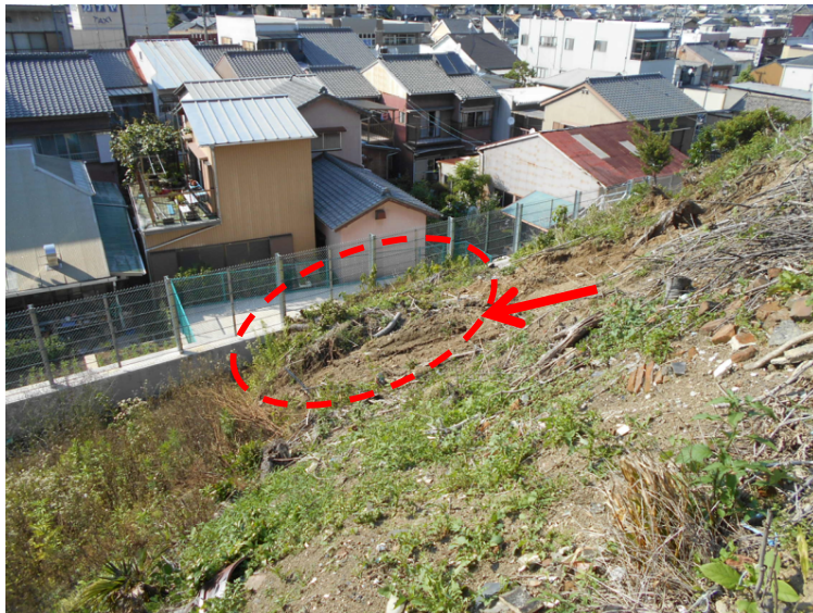
がけ崩れ発生直後 (H29.6.23)
