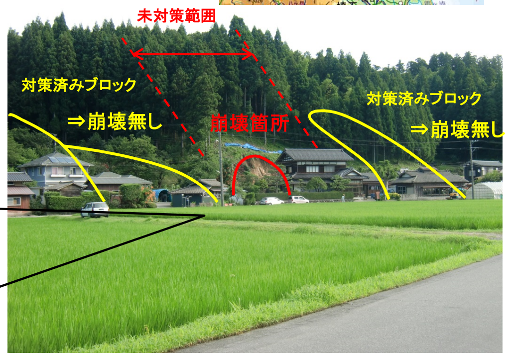
崩壊箇所と周辺状況
