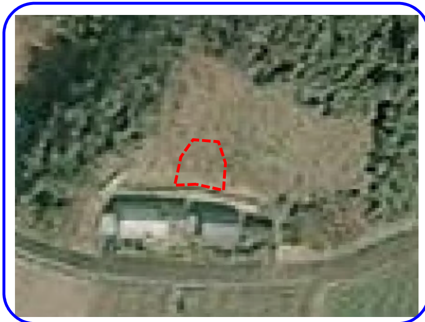
がけ崩れ発生前 (H29年度)
