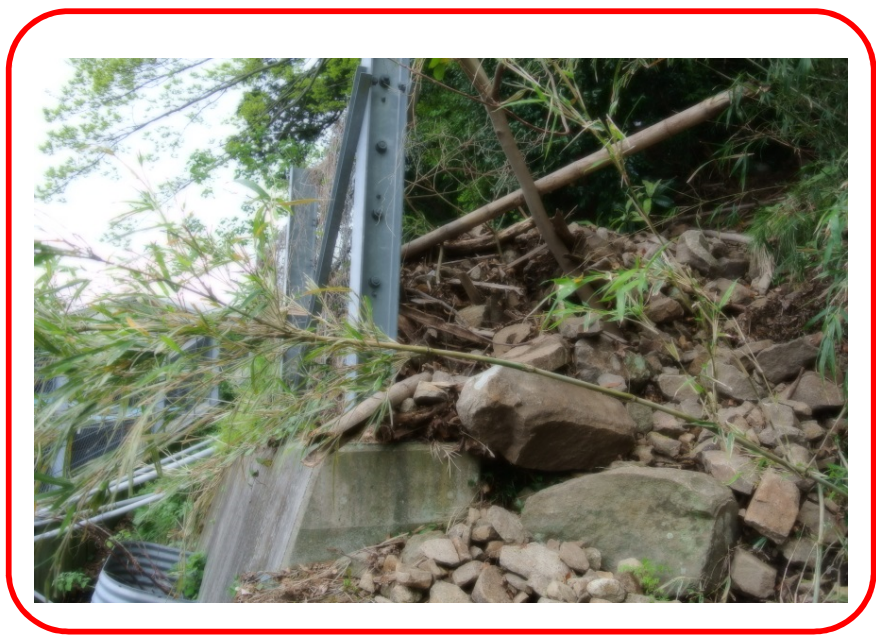
がけ崩れ発生直後 (H29.4.21)
