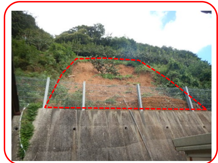
がけ崩れ発生直後(H29.10.23)
