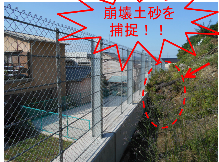
がけ崩れ発生直後 (H29.6.23)
