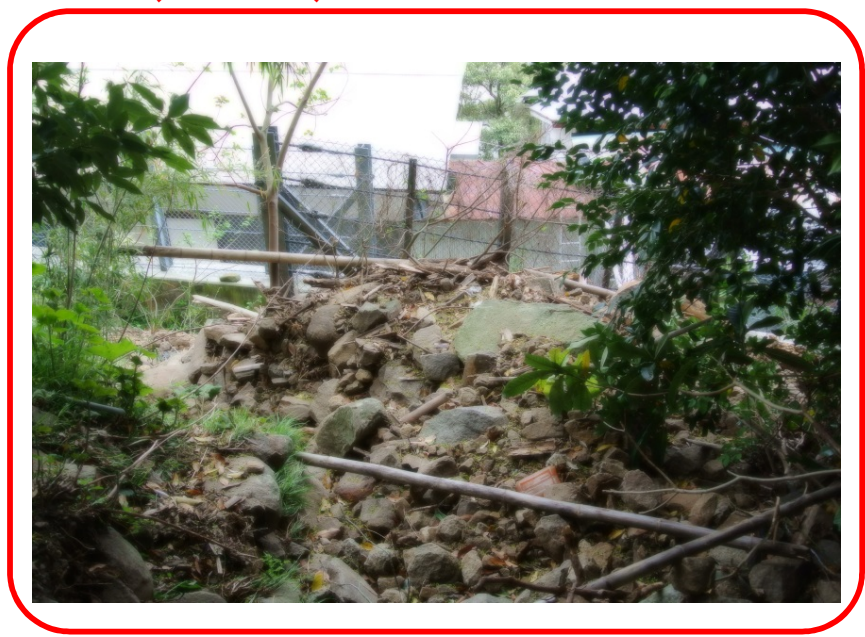
がけ崩れ発生直後 (H29.4.21)
