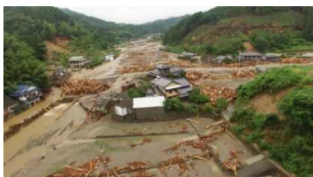
赤谷川における土砂・流木被害
