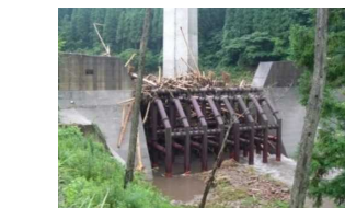
透過型砂防堰堤による流木捕捉事例
