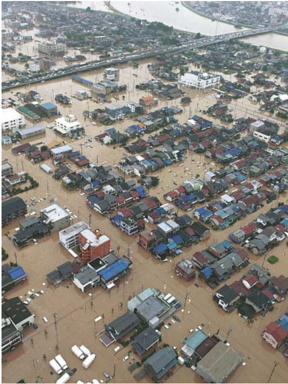
[上] 新川の決壊で、瞬間に一面泥海と化した西枇杷島町 [左] 約 100 m にわたって決壊した新川左岸堤防
