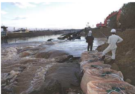
決壊個所では懸命の復旧工事が行われた
