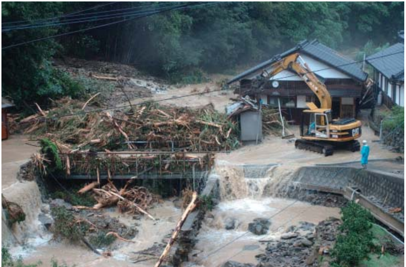
▲対岸で発生した土石流の直撃を受けた落合自治会館〔写真提供／読売新聞社〕
