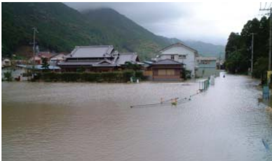
▲台風11号による相野谷川の浸水被害（紀宝町高岡地区）〔写真提供／三重県紀宝町〕
