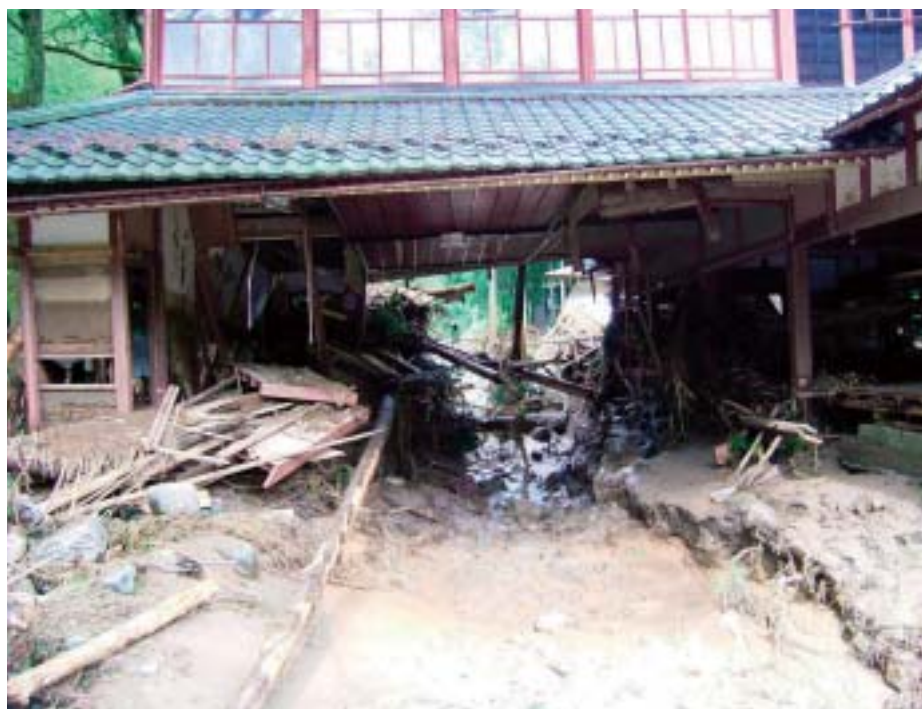
▲1階部分が押し流された民家（池田町松ヶ谷）〔写真提供／近畿地方整備局河川部〕
