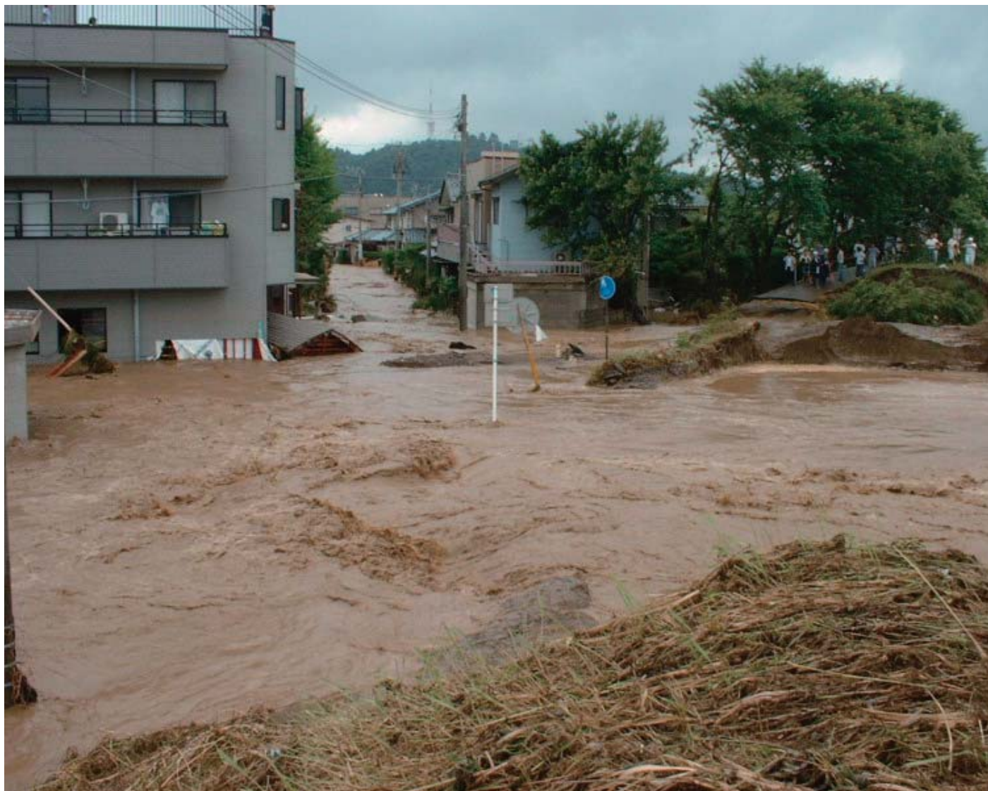
▲足羽川左岸の堤防が決壊し濁流に襲われる市街地（福井市春日1丁目）〔写真提供／近畿地方整備局河川部〕
