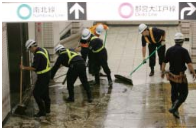
▲駅構内に流れ込んだ泥を掃除する職員（東京メトロ麻布十番駅）〔写真提供/読売新聞社〕
