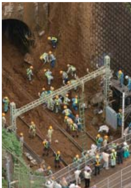
▲土砂崩れが発生した京浜急行電鉄日ノ出町駅付近〔写真提供/共同通信社〕
