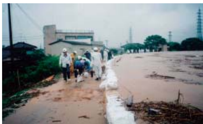
▲五十嵐川の越水を食い止める水防活動（三条市三竹地区）〔写真提供／新潟県土木部〕
