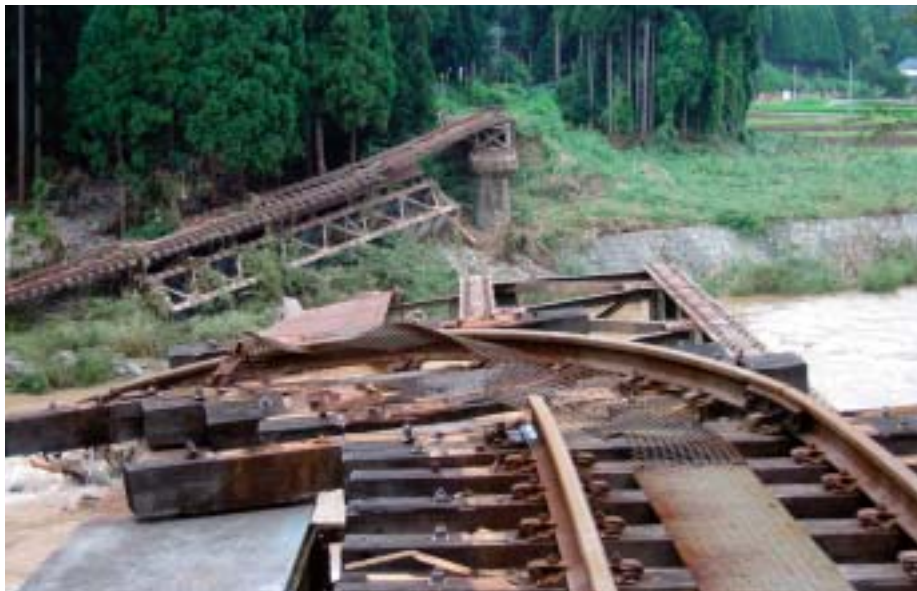
▲流失したJR越美北線の足羽第3鉄橋（美山町）〔写真提供／福井県土木部〕
