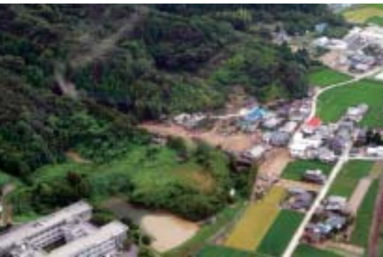
▲愛媛県新居浜市神郷の土砂災害現場〔写真提供/四国地方整備局〕
