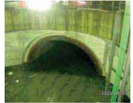
地下調整池への緊急流入措置 〔資料提供 / 東京都建設局河川部〕
