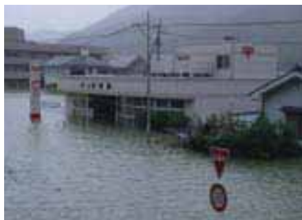
▲浸水した北川郵便局 〔写真提供／宮崎県北川町〕
