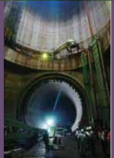
緊急流入措置を実施した神田川・環状7号線地下調整池妙正寺川発進立坑（写真提供／読売新聞社）
