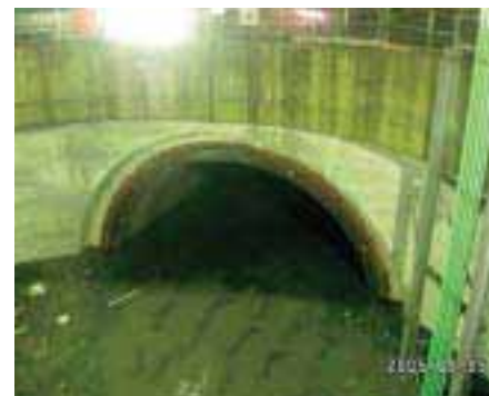
▲地下調整池への緊急流入措置 〔資料提供／東京都建設局河川部〕
