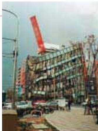
◀ 阪神・淡路大震災で倒壊したビル（神戸市兵庫区） 〔写真提供 / 読売新聞社〕
