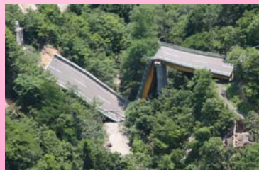
▲国道342号祭時大橋の落橋（岩手県一関市）
