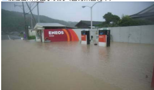
▲串間市内の浸水状況（宮崎県：市木川のはん濫による）
