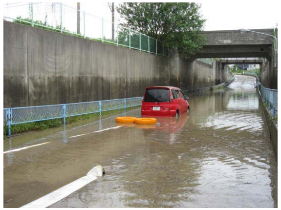
▲ 幸田町内の浸水状況
