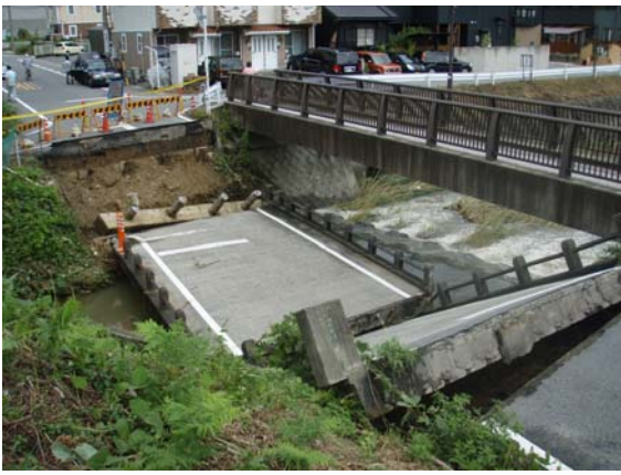
りゅうせんじ みかわ ▲ 竜泉寺川「三河橋」の落橋（愛知県岡崎市）
