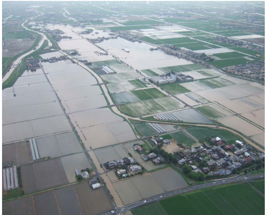
▲ 筑後川支川城原川沿川の浸水状況（佐賀県神埼市）
