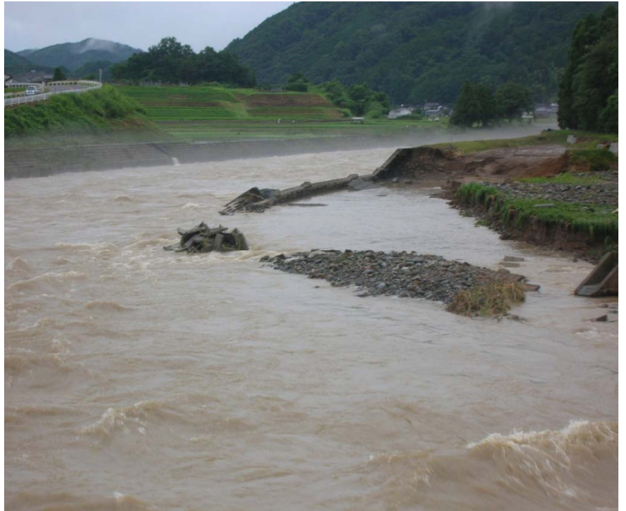
▲ 吉井川水系吉野川（県管理）の施設被害状況（岡山県美作市）
