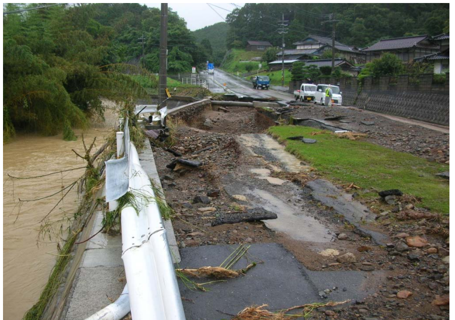
▲ 山鹿川沿川の別所地区の被災状況（岡山県美作市）
