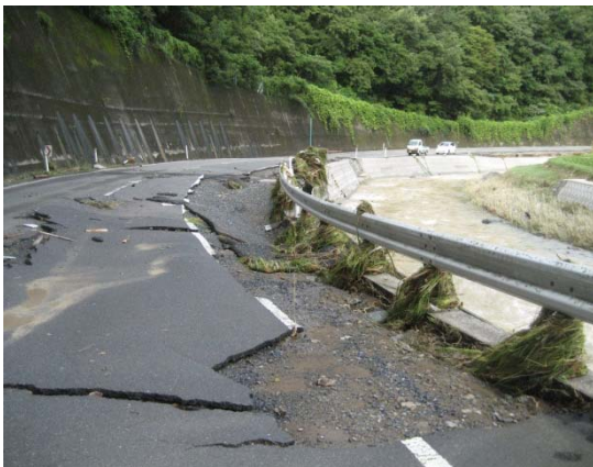
▲ 吉井川水系山鹿川（県管理）と 県道の被害状況（岡山県美作市）
