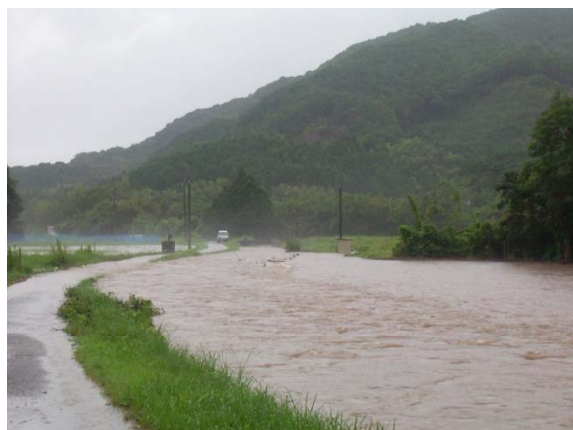
▲ 後川（県管理）の状況（高知県四万十町）
