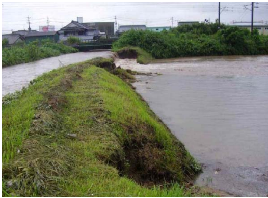
▲ 金立川（県管理）の堤防決壊状況（佐賀県佐賀市）
