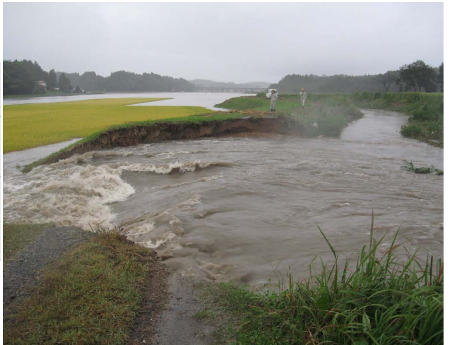
▲ 北上川水系照越川(県管理)の堤防決壊状況(宮城県栗原市)
