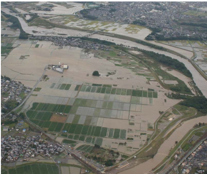
▲ 松阪市嬉野平生町付近の浸水状況(三重県松阪市)
