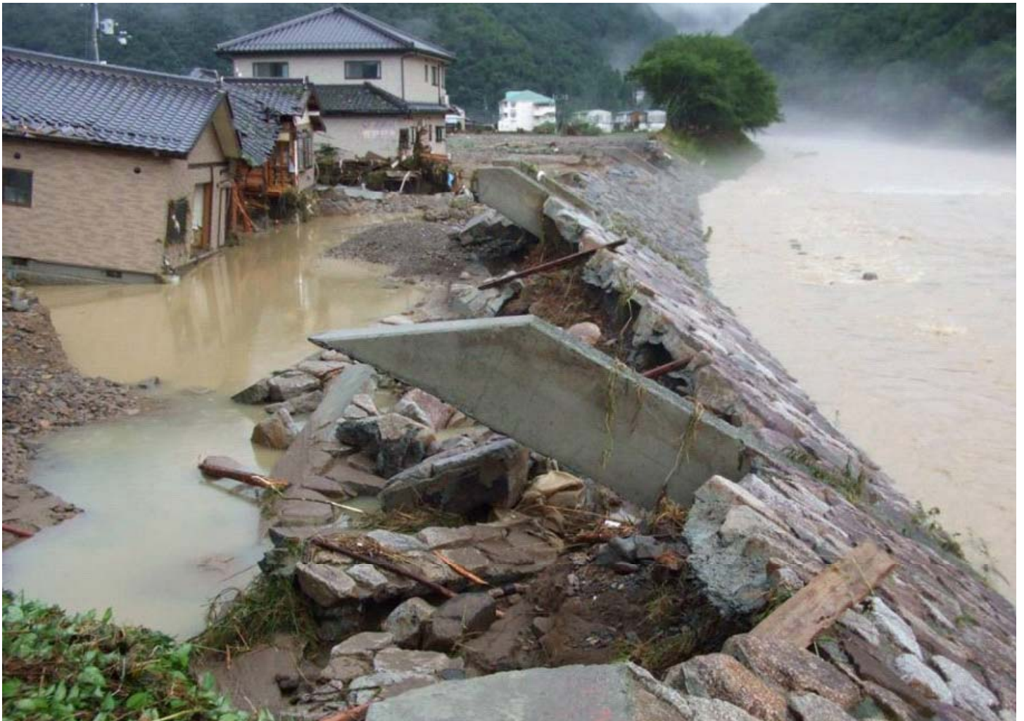
▲ 千種川水系佐用川(県管理)沿川の久崎地区の被災状況(兵庫県佐用町) 兵庫県提供
