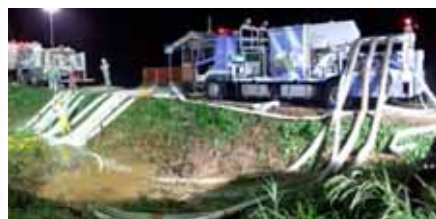
新潟県田上町川坂田排水状況
