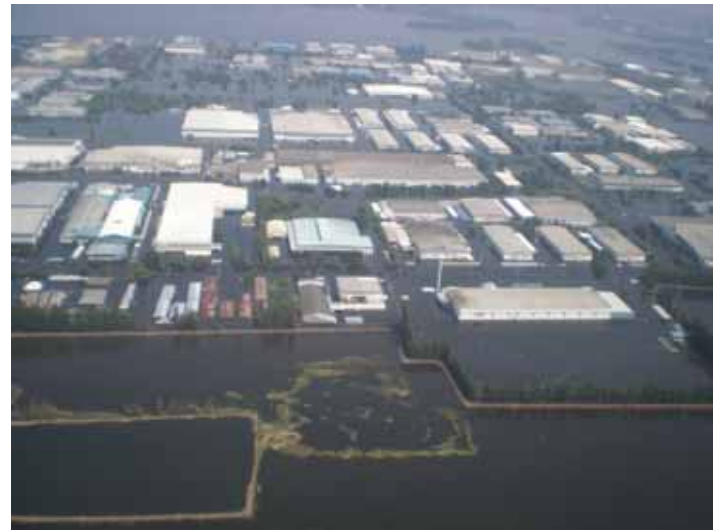
工業団地の周りを囲む輪中堤を超えて工場建屋は完全に水没(10月21日) (ロジャナ工業団地:日本企業が最も多く進出している工業団地)
