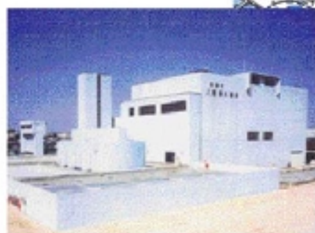
八潮排水機場(綾瀬川放水ポンプ 平成10年50m 3 /s増設)
