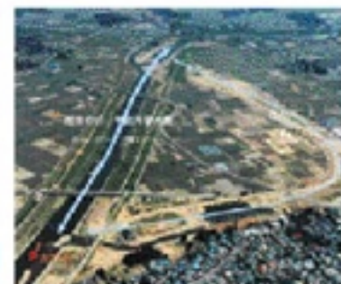
平成6年1月に洪水した早出川排水路
