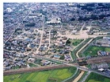
平成3年9月内津川堤防による浸水状況
