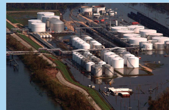
▲ ハリケーンにより浸水したガソリン備蓄タンク (アメリカ・ニューオーリンズ、ルイジアナ州)
