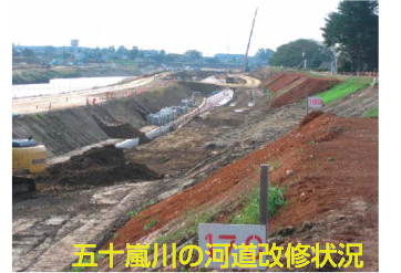
五十嵐川の河道改修状況
