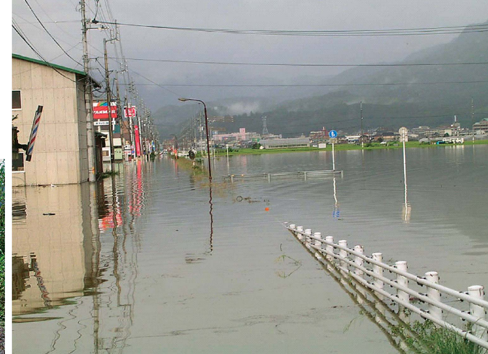
▲ 肱川の浸水状況（愛媛県大洲市）
