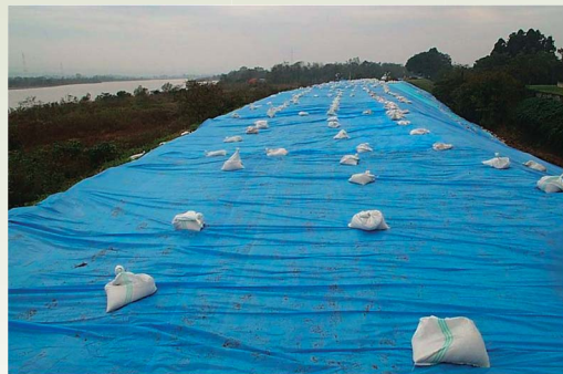
① 応急復旧後（長岡市（旧越路町）三俵野）
