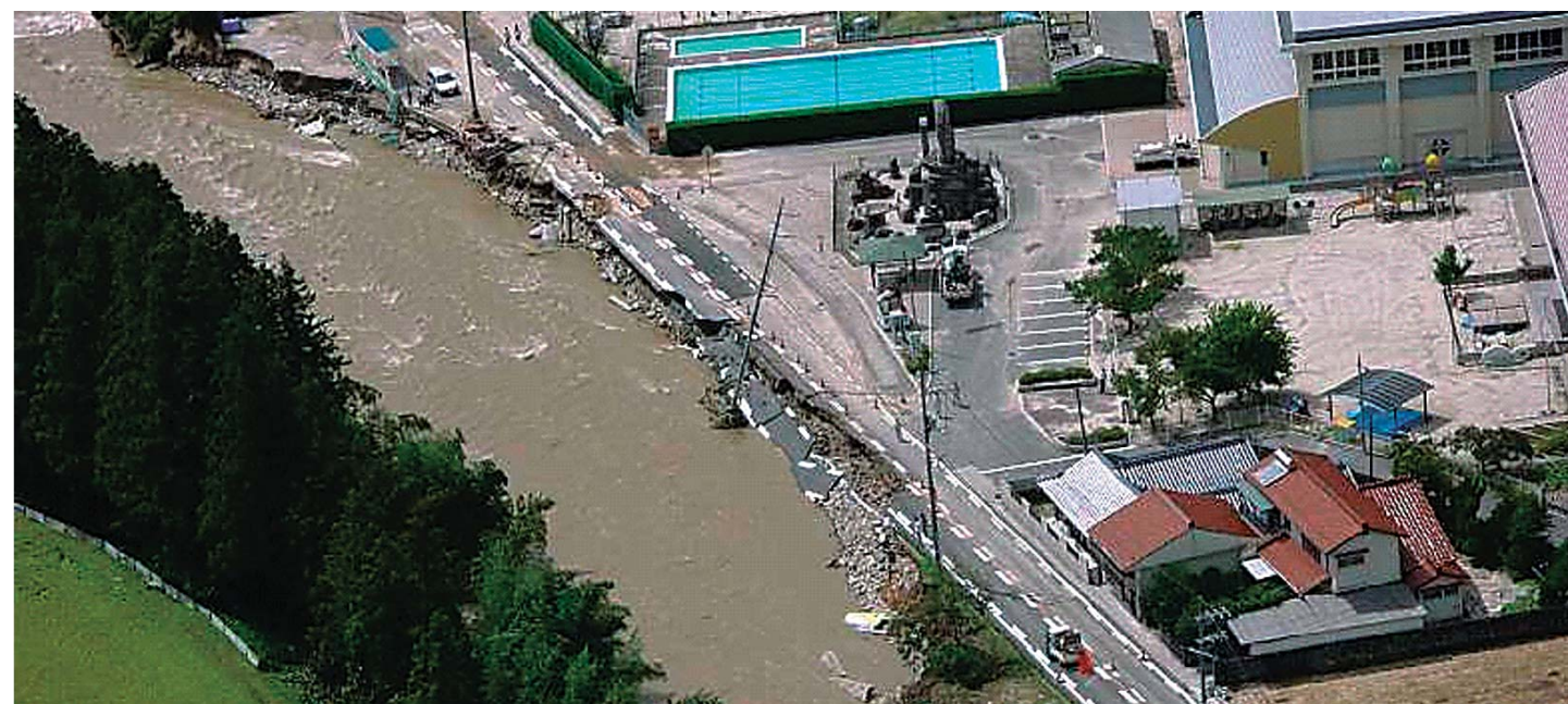
▲ 玖島川の被災状況（広島県廿日市市）
