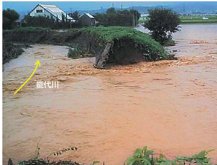
▲ 能代川の破堤状況（新潟県村松町）
