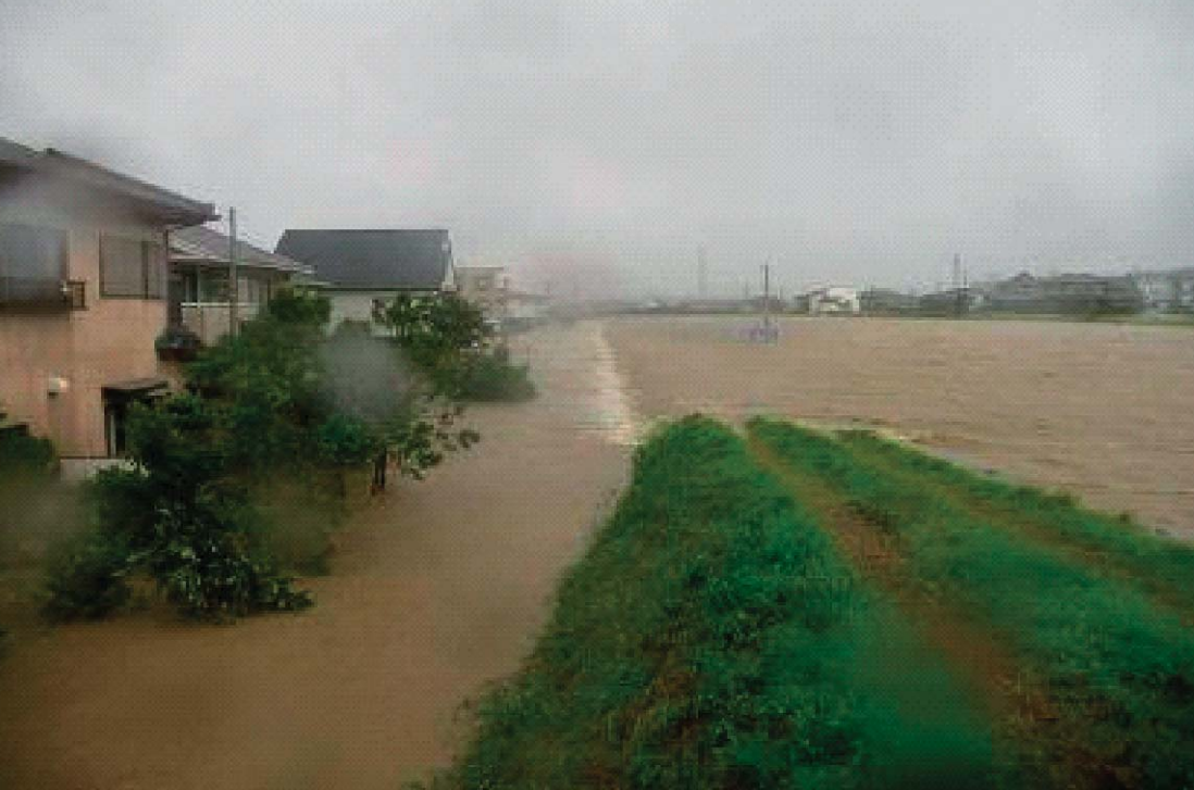
▲ 大淀川支川大谷川の越水状況（宮崎市）
