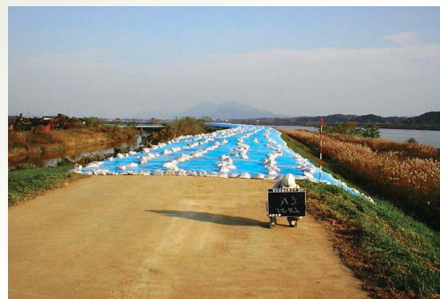
② 応急復旧後（長岡市（旧中之島町）中条）
