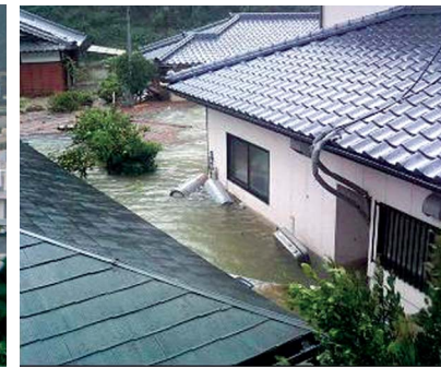
▲ 五ヶ瀬川支川祝子川の浸水状況（宮崎県延岡市）
