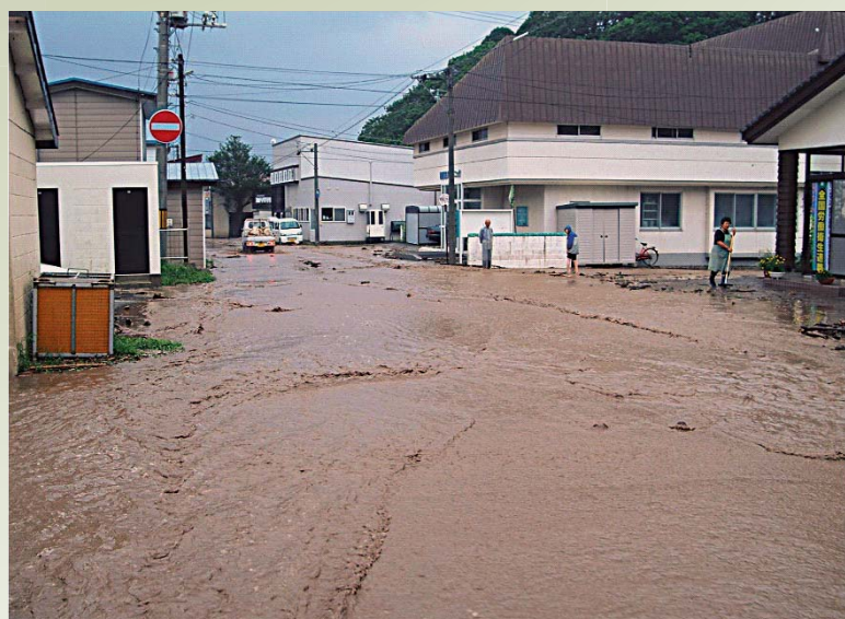
▼ 大松前川の被災状況（松前町）
