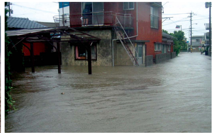
▲ 大野川支川乙津川の浸水状況（大分市）
