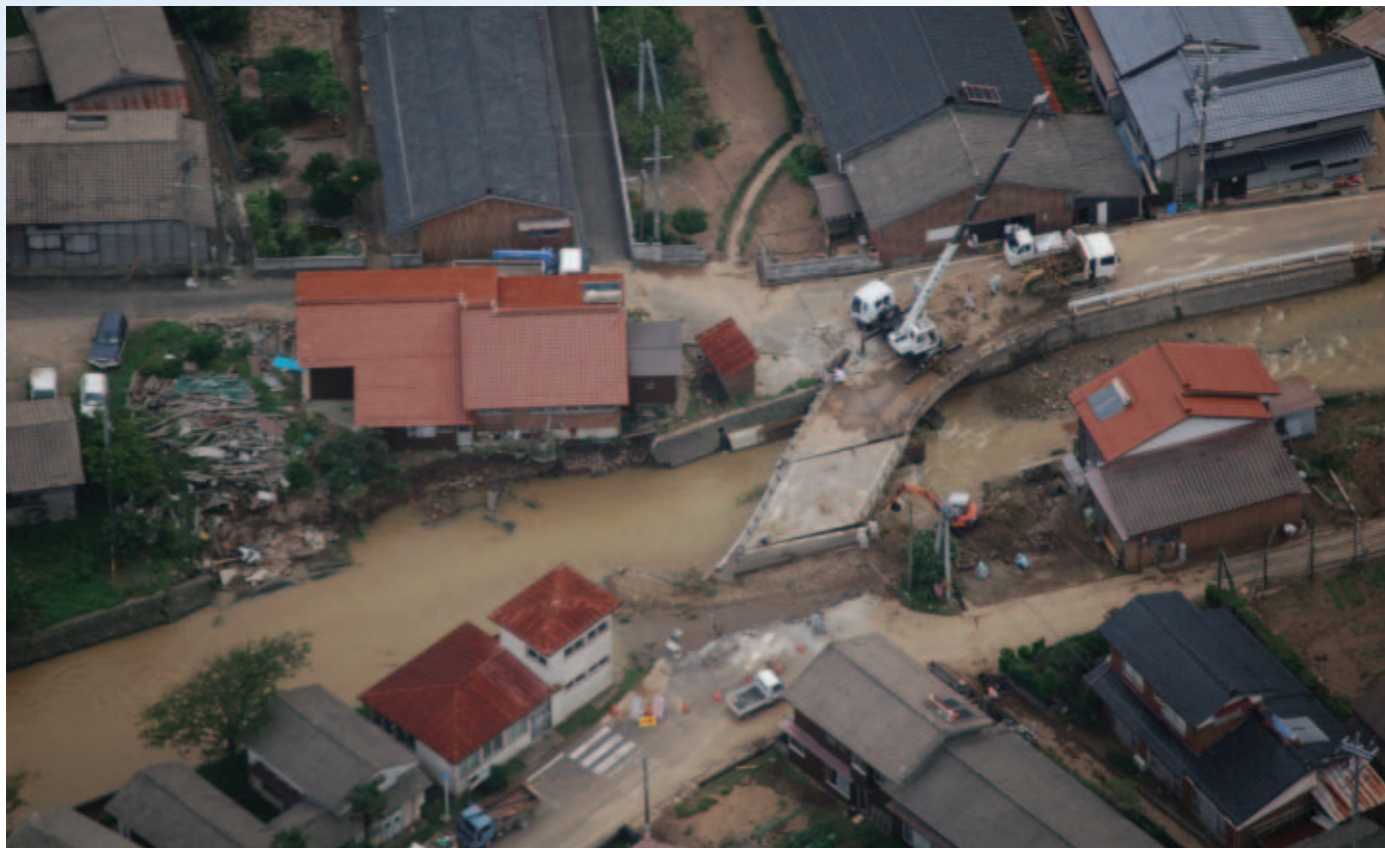
▲ 大久川の被災状況（島根県隠岐の島町）
