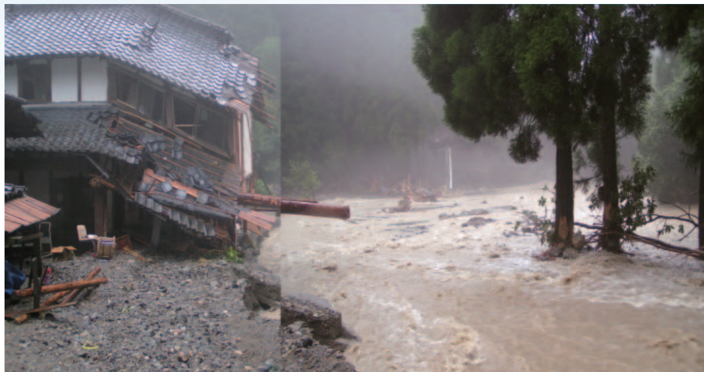
▲ 柏川の被災状況（熊本県美里町）
