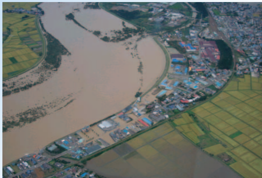
▲ 米代川の洪水状況（秋田県能代市）
