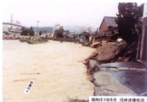
昭和51年6月 河津決壊状況
