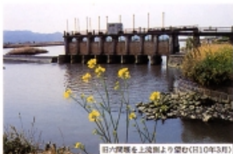
旧六間堰を上流側より望む(平成10年3月)
