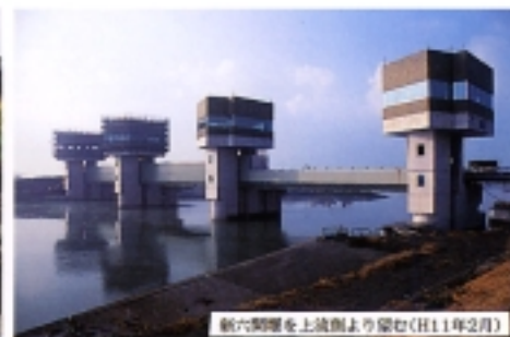
新六間堰を上流側より望む(平成11年2月)
