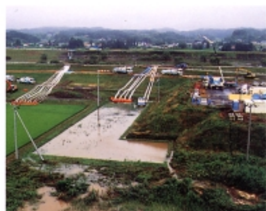
7月14日／鶴田川：破堤箇所排水ポンプ車活動状況(宮城県松島町)
