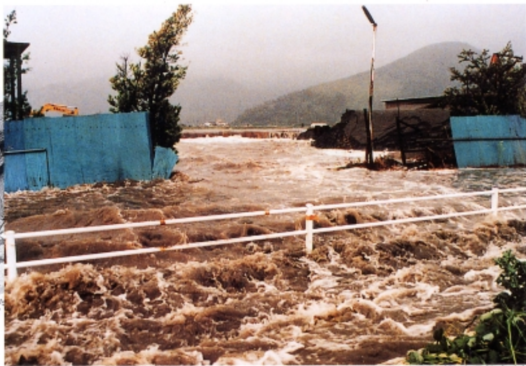
9月24日/白川：堤防越流状況(熊本県熊本市)
