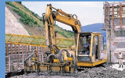
バイバックによる締め固め
