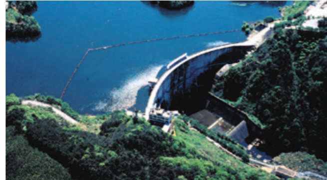
青蓮寺ダム(水資源機構)
