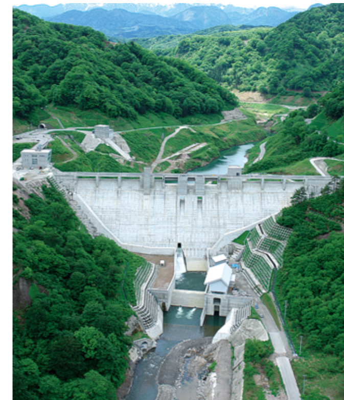
横川ダム(北陸地方整備局)
