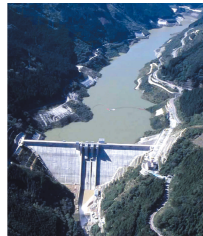
滝沢ダム(水資源機構)
