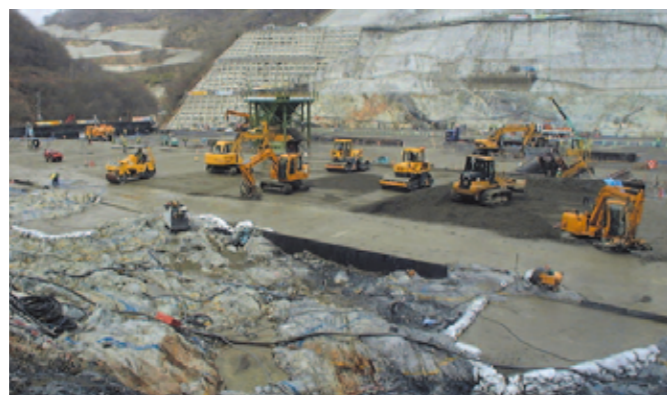
滝沢ダム(水資源機構)
