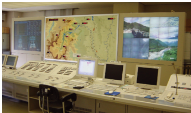
ダム管理用設備
