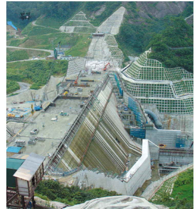
横川ダム (北陸地方整備局)
