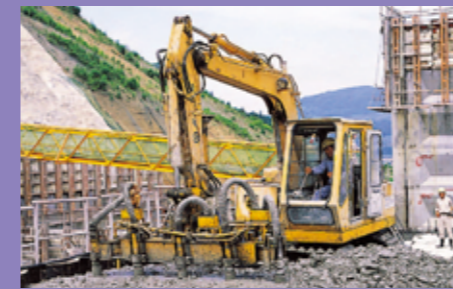
パイバックによる締め固め
