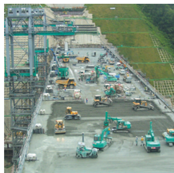
長井ダム(東北地方整備局)
