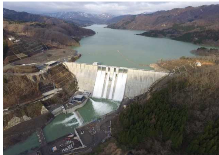
試験湛水状況 H28.4撮影
