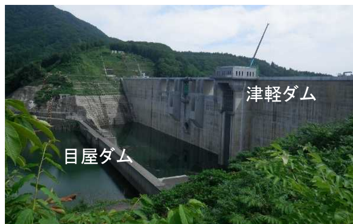
試験湛水状況 H28.8撮影
