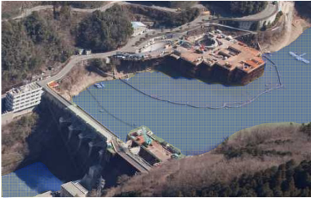
ダムを運用しながら、施設を改良
