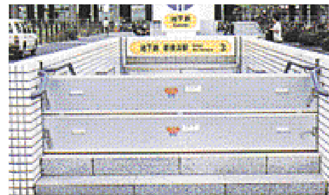
浸水防止施設の整備イメージ (止水板)
