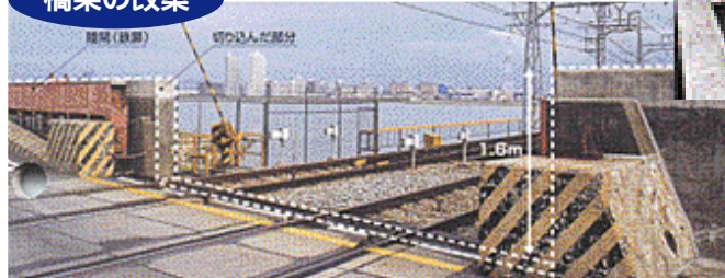
阪神西大阪線 淀川橋梁 淀川 大阪府 橋梁が堤防を切込んでいるため、高潮による浸水防御を陸閘(狭扉)に頼っているため、架替えを実施。
