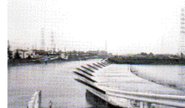
越流堤 (越流状況)
