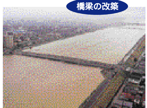
国道1号線 一色大橋 庄内川 愛知県 橋梁の桁下高が低く流下能力のネックとなっており、洪水時に危険となるため架替えを実施。
