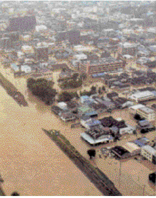
新川の破堤状況 (名古屋市)
