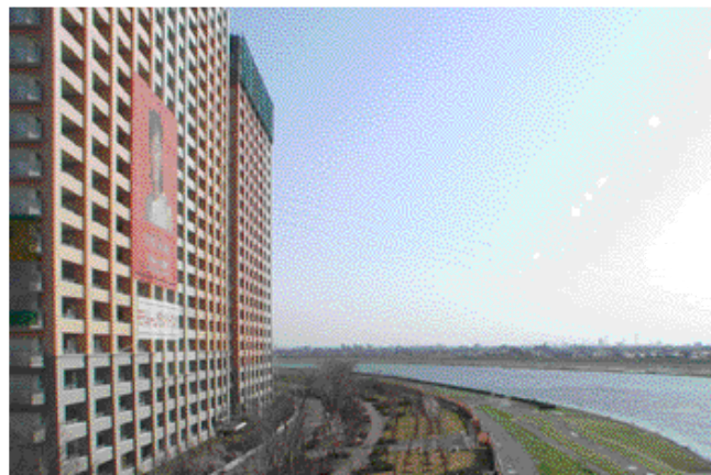
高規格堤防上に建設中の民間マンション 江戸川 千葉県市川市
