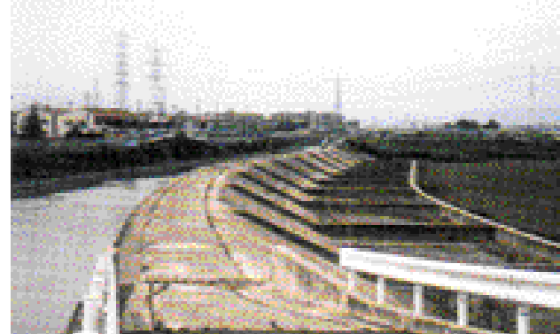
越流堤 (平常時)
