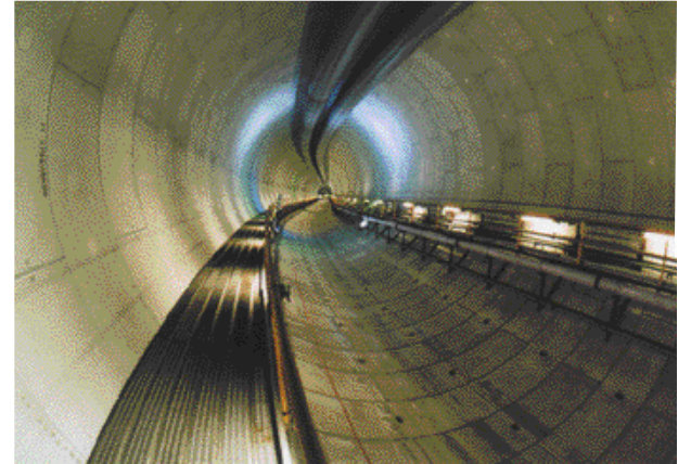
導水トンネル
