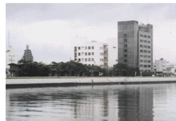
防潮堤防設備
