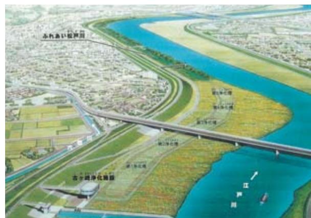
古ヶ崎浄化施設（江戸川）
