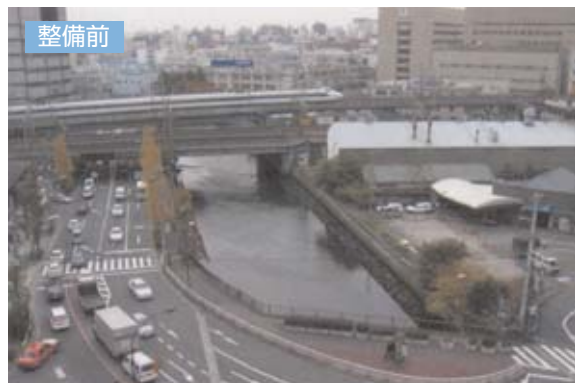
目黒川（東京都） 防潮堤防の整備
