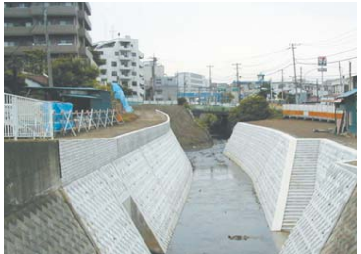
本川河道改修後
