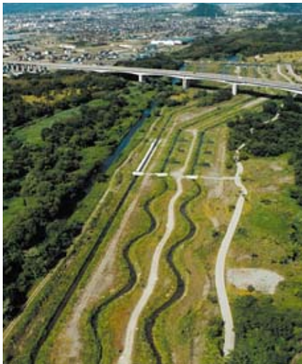
■空間の形状・流量・流速などをコントロールできる実験河川
