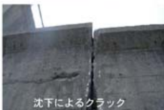
沈下による段差の発生
