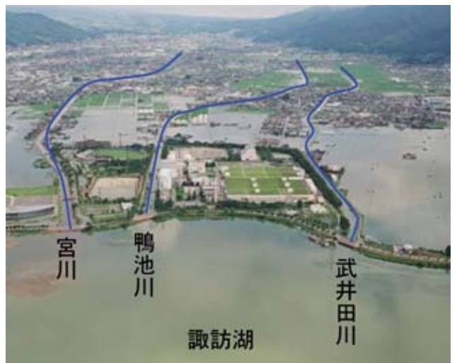
諏訪湖（長野県）平成18年7月
