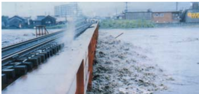
JR白川第一橋梁 白川（熊本県）
