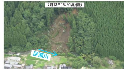
7月13日 15:30頃撮影 ちくごがわ こせがわ 筑後川水系巨瀬川（福岡県うきは市） 崖崩れにより土砂が河川に流れ込み流下を一部阻害 （応急対策実施中）
