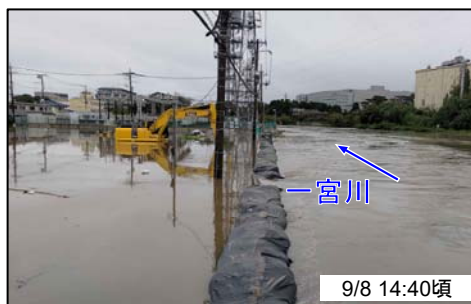
一宮川水系一宮川の浸水状況 (千葉県茂原市)
