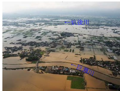
ちくごがわ こせがわ くるめし 筑後川水系巨瀬川（福岡県久留米市） （家屋浸水あり）
