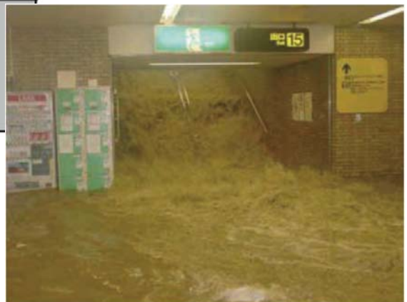
地下街の浸水状況 H15.7 福岡水害 (博多駅) はかた
