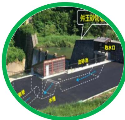
発電ポテンシャルを有する既設砂防堰堤を活用した小水量発電の普及・拡大を推進
