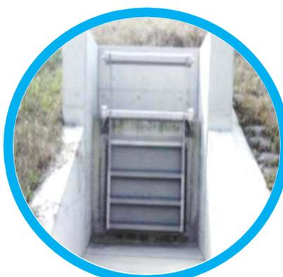
河川管理施設において、操作員不足・安全確保等のため操作に動力を要さないフラップゲートへの転換等により無動力化を推進
