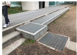
学校のグラウンドに雨水貯留する例【熊本県熊本市】
