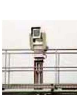
CCTVカメラの整備
