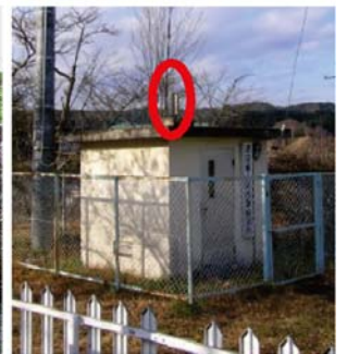
雨量計の整備
