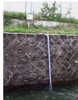
水位計の整備
