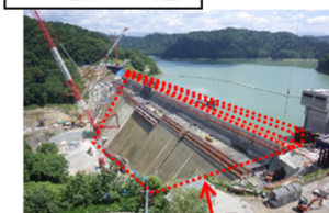
ダム建設・ダム再生
