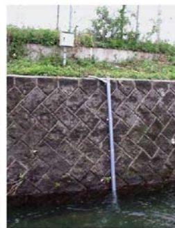
水位計の整備
