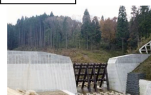
砂防関係施設整備
