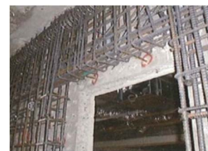
処理場の耐震化（躯体補強）
