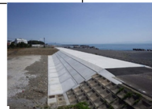
海岸保全施設整備
