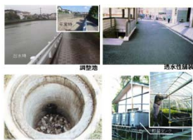
雨水貯留浸透施設の例
