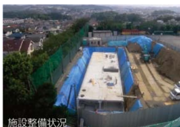
施設整備状況
