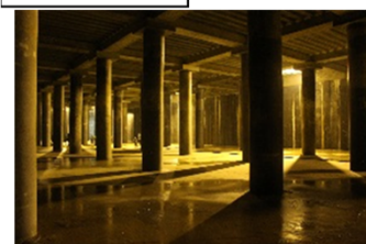
大規模地下貯留施設
