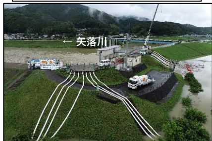
排水作業で堤防天端を使用すると復旧活動で堤防上を往来できない
