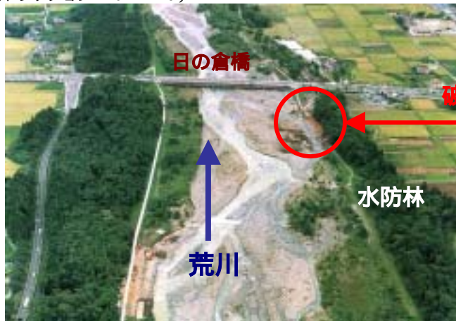
平成10年8月出水の破堤で効果を発揮した水防林
