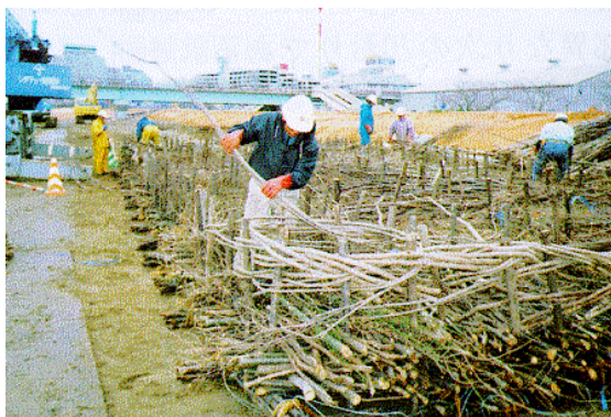
粗朶沈床を編んでいる状況
