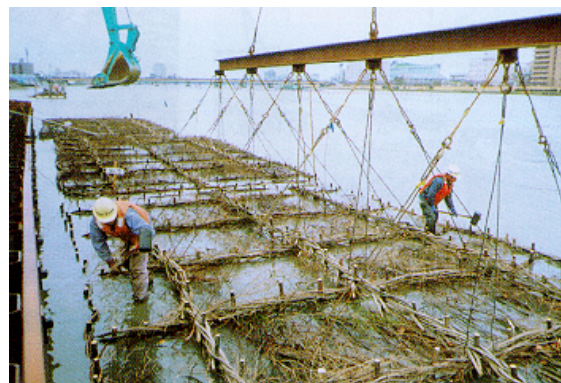
できた粗朶沈床をクレーンで設置 (後から石を投入する)
