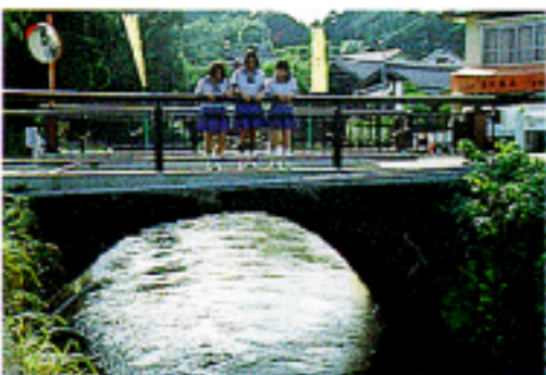
67 地藏橋（大津町）町指定文化財 架橋 文化11年（推定） 石工 勘太郎（推定） 長さ7.50m 幅4.35m 高さ3.65m 径間6.00m 供矢3.00m
