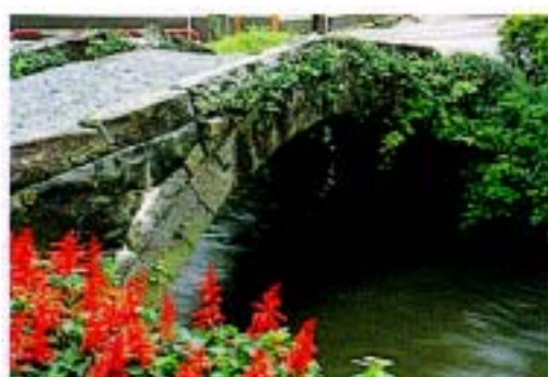
73 井口橋（菊陽町） 架橋 江戸末期（推定） 石工 不明 長さ10.75m 幅3.00m 高さ2.65m
