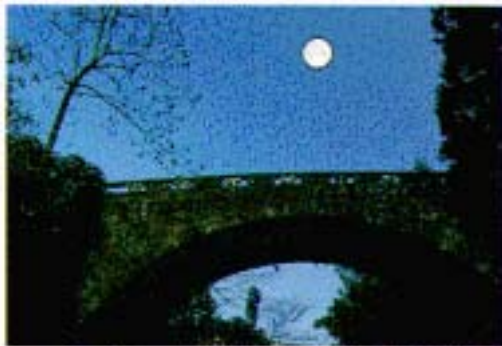
48 永山橋（菊池市）県指定重要文化財 架橋 旧文政7年・新明治11年 石工 旧・小坂勘五郎 新・橋本勘五郎 長さ61.00m 幅4.60m 高さ18.00m 径間20.60m 供矢7.90m
