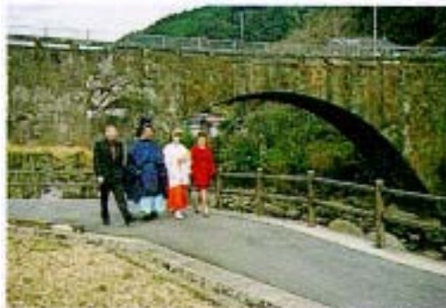
53 立門橋（菊池市）県指定重要文化財 架橋 万延元年 石工 宇市 長さ75.00m 幅3.60m 高さ11.40m 径間21.70m 供矢8.60m
