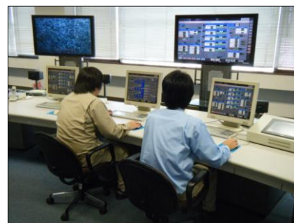
浄水場での配水圧、配水量の調整(埼玉県)
