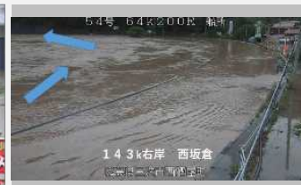
江の川の溢水状況 （広島県三次市）
