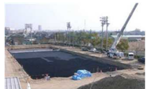
グラウンドの雨水貯留施設(工事状況)【愛知県岡崎市】
