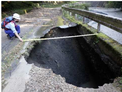
道路の被害状況調査（川根本町）
