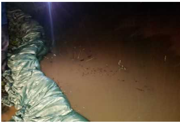
つるた 青森県鶴田町消防団 積み土のう工 (令和4年8月9～12日) いわき 岩木川
