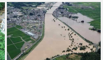
最上川の氾濫状況 （山形県大石田町）
