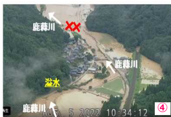
くずりゅう かひる 九頭竜川水系鹿蒜川の堤防決壊による氾濫状況（福井県 南越前町）
