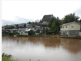
五ヶ瀬川沿川の内水による浸水状況 （宮崎県延岡市）
