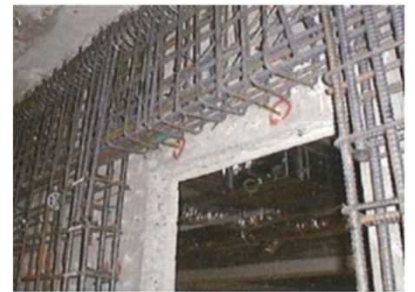
処理場の耐震化（躯体補強）
