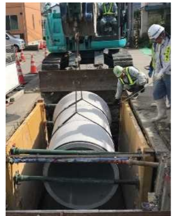
枝線(増径)施工状況
