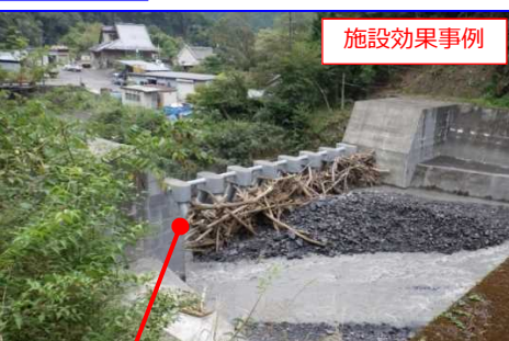
砂防堰堤が土石流を捕捉
