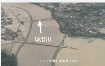
球磨川の氾濫状況 （熊本県人吉市）
