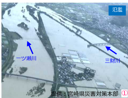
ひとつせ さんざい 一ツ瀬川水系一ツ瀬川、三財川の さいと しんとみ による浸水状況 (宮崎県西都市・新富町)
