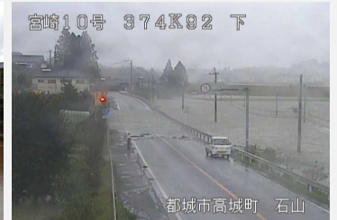
大淀川沿川の内水による浸水状況 （宮崎県都城市）
