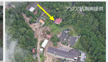
土砂災害の状況 （長崎県雲仙市）
