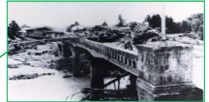
流木の山となった小国橋
