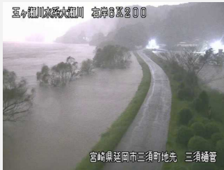
大瀬川の洪水状況 （宮崎県延岡市）
