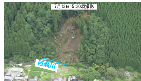
7月13日 15:30頃撮影 ちくごかわ こせがわ 筑後川水系巨瀬川（福岡県うきは市） 崖崩れにより土砂が河川に流れ込み流下を一部阻害 （応急対策実施中）
