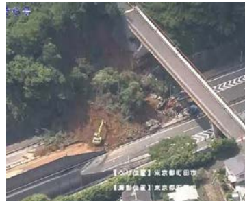
防災ヘリによる調査 (東京都町田市)
