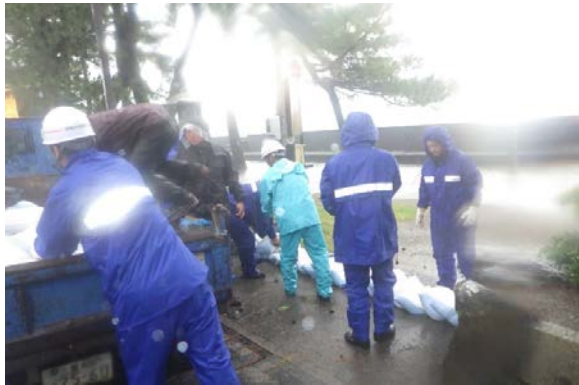
いせ 三重県伊勢市消防団 積み土のう工 ふたみ (令和5年6月2～3日) 二見地区海岸
