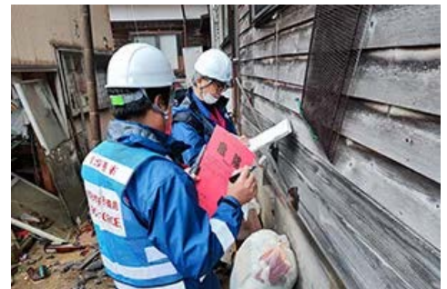
被災建築物応急危険度判定 (石川県穴水市)
