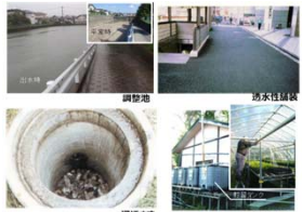
雨水貯留浸透施設の例
