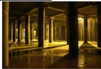
大規模地下貯留施設
