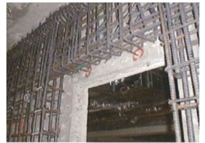
処理場の耐震化（躯体補強）
