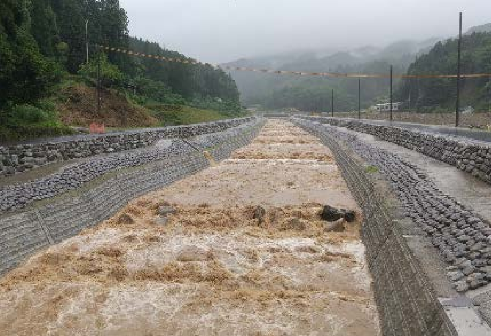
【整備後】 令和5年6月29日からの大雨による出水時の筑後川水系赤谷川（福岡県朝倉市） ちくごがわ あかたにかわ あさくら
