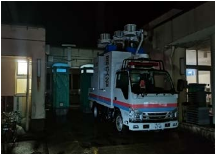
避難所へ照明車からの電源支援 (石川県珠洲市)
