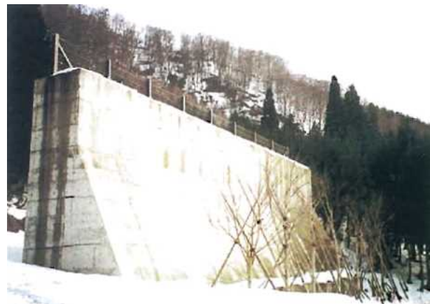
● 雪崩防護擁壁(富山県南砺市利賀村)
