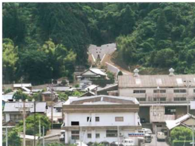
●土石流危険溪流に設置された上の谷沢砂防堰堤(長崎県島原市)
