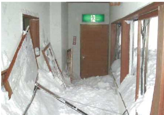
● 住宅被害状況(長野県松本市安曇)
