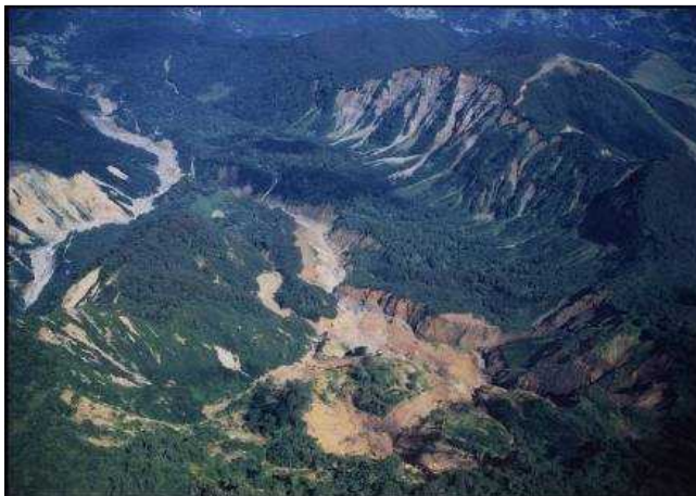
●姫川上流の稗田山崩壊地（長野県北安曇郡小谷村）
