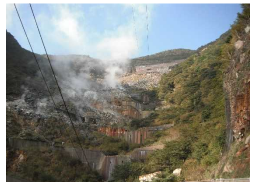
●箱根火山における土石流対策(神奈川県足柄下郡箱根町強羅)
