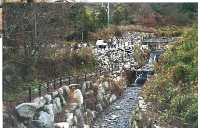
●地元の地域整備計画と一体化した整備が図られた白光寺川(山口県大島郡大島町)
