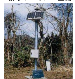
GPSを活用した地すべり監視
