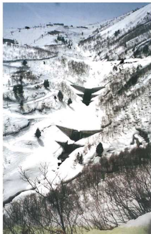
●雪崩の発生危険箇所をもつ砂防堰堤(長野県北安曇郡白馬村)
