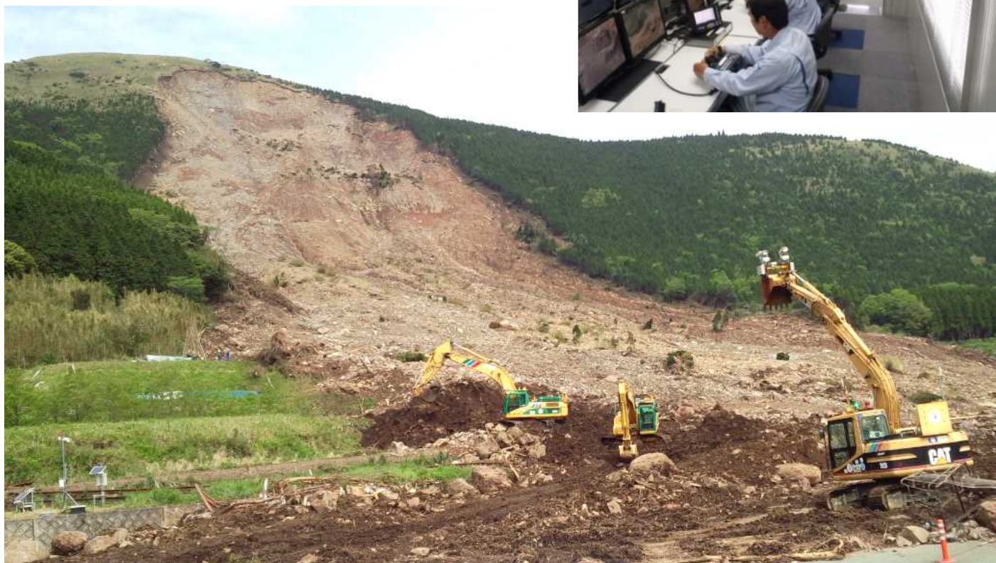
阿蘇大橋地区における無人化施工
