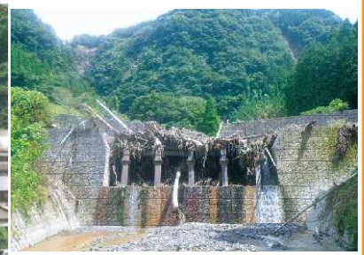
●土石流を止めた平保の木川砂防堰堤(熊本県阿蘇市)
