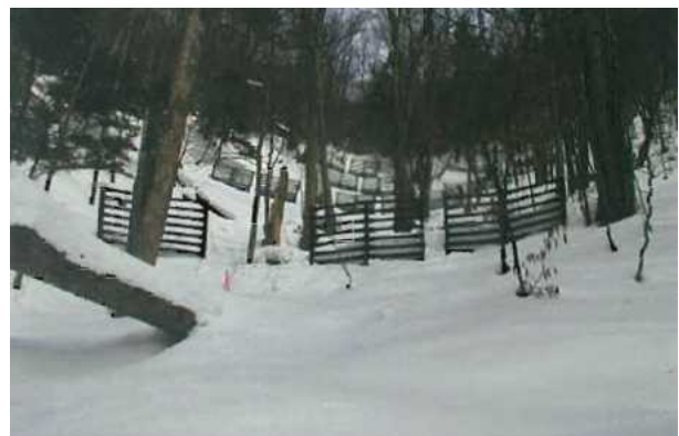
● 雪崩予防柵工(長野県松本市安曇)
