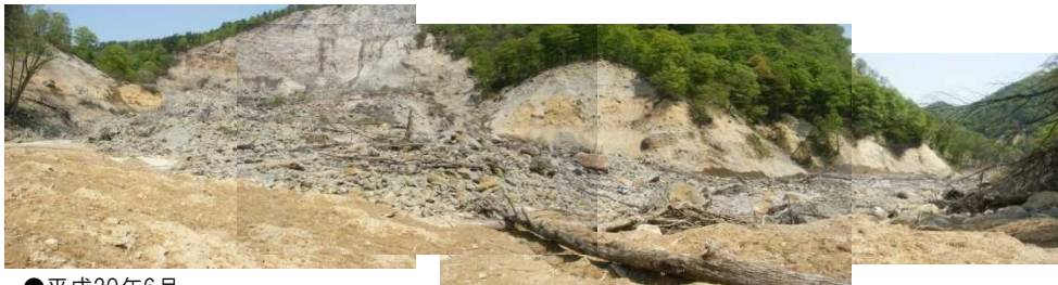
●平成20年6月 岩手・宮城内陸地震における被災状況
