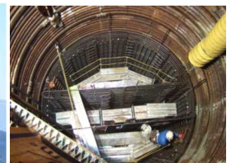
深礎工の整備
