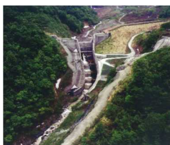
●焼山火山噴火に伴う火山泥流・土石流に対処する火打山川砂防堰堤(新潟県糸魚川市)
