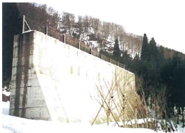
● 雪崩防護擁壁(富山県南砺市利賀村)
