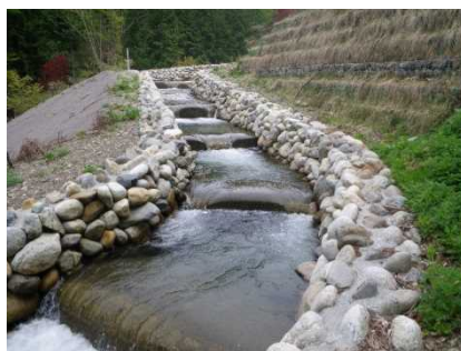
●魚類に配慮した金原砂防堰堤に設置された魚道とその観察窓（長野県）
