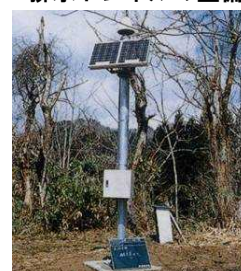
GPSを活用した地すべり監視
