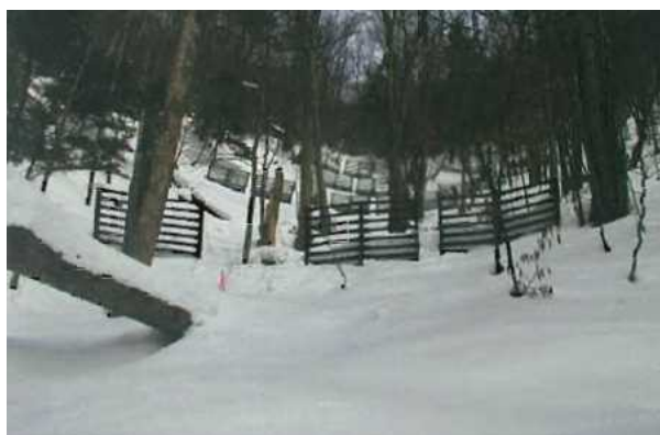
● 雪崩予防柵工(長野県松本市安曇)
