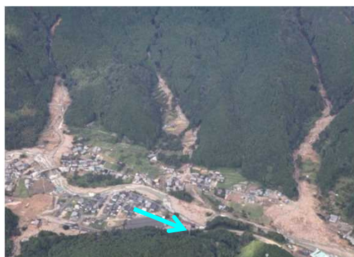
●平成23年9月台風第12号による被災状況 （和歌山県那智勝浦町）
