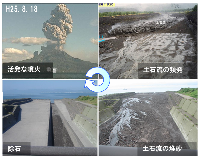
【桜島における除石等による砂防設備の機能確保】
