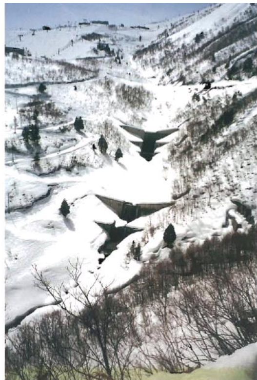
●雪崩の発生危険箇所をもつ砂防堰堤(長野県北安曇郡白馬村)
