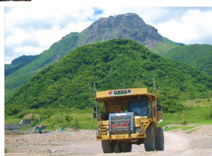
右図：無人化施工重機
