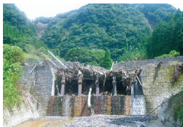
●土石流を止めた砂防堰堤 (熊本県阿蘇市)
