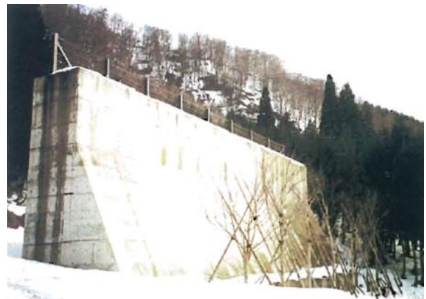
● 雪崩防護擁壁(富山県南砺市利賀村)
