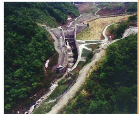
●焼山火山噴火に伴う火山泥流・土石流に対処する火打山川砂防堰堤(新潟県糸魚川市)
