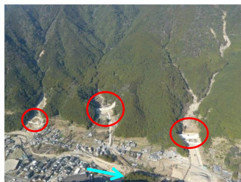
●直轄砂防災害関連緊急事業により完成した砂防堰堤
