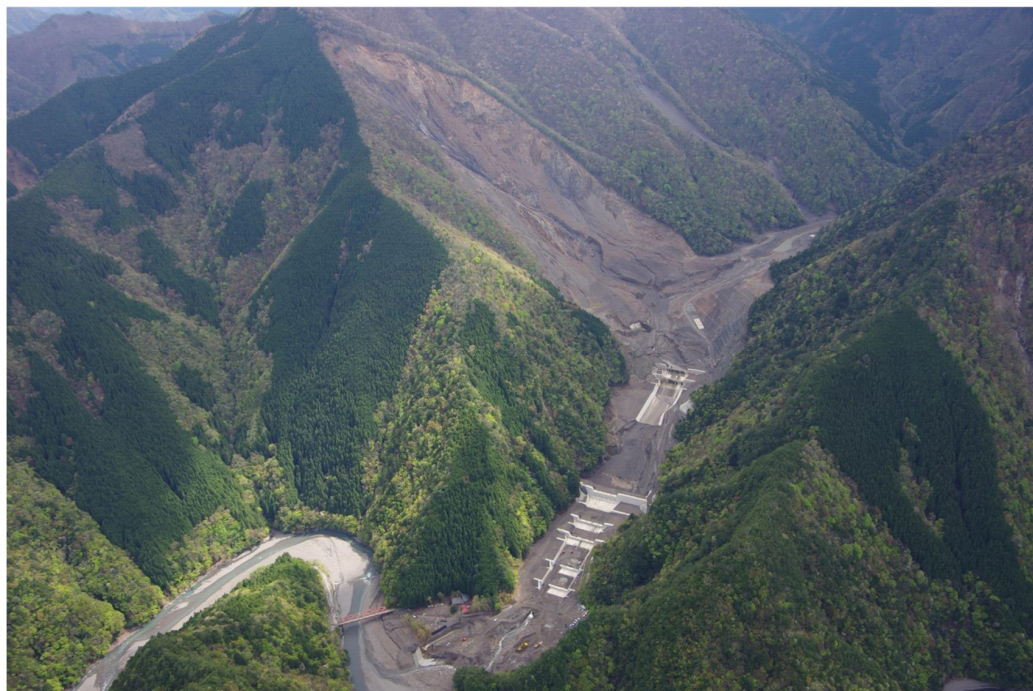
●川原樋川床固工群(奈良県五條市)
