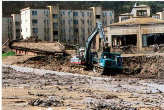
無人化施工によるやすらぎ家付近埋塞土掘削の状況 (H12.8.30 撮影)
