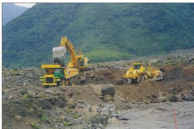
写真 3-3 無人化施工の状況
