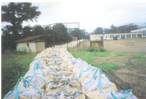
小学校グラウンドに設置された大型土のう（H12.7.17 撮影）
