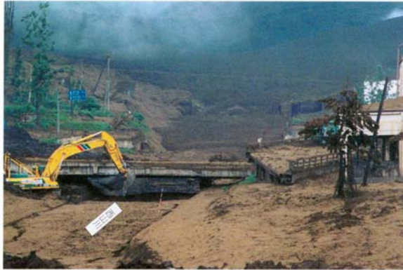
無人化施工による埋塞土掘削の状況 (H12.7.14 撮影)
