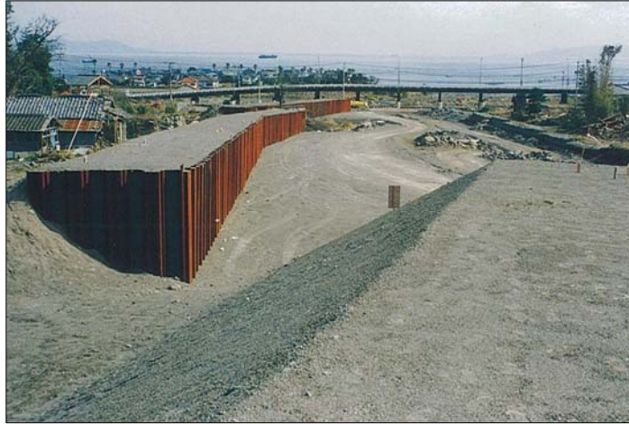
写真 3-1 仮設導流堤
