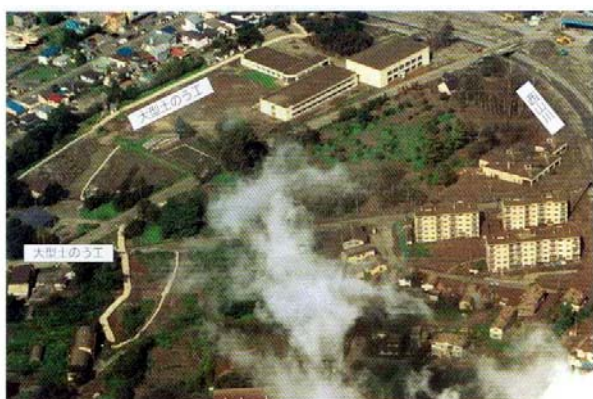
大型土のう設置状況全景（H12.8.27 撮影）
