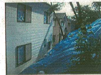
裏山の崩壊による崖下住宅への危害
