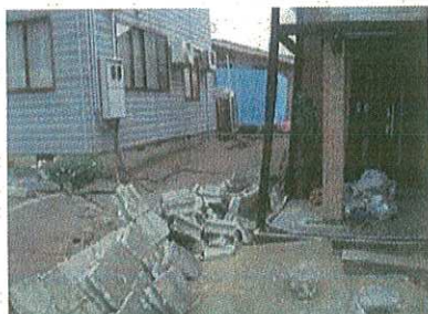
地盤変動による被害が甚大であった地点の状況
